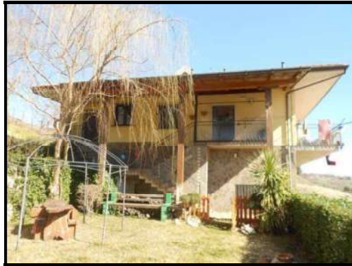
Prospetto Ingresso Fabbricato
