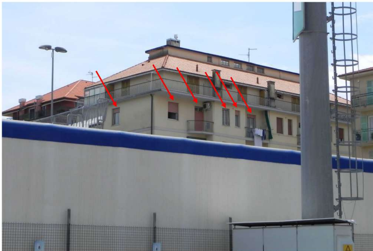
Foto 9 e 10 - Vista del 4° del condominio di C.so Lavagna 95 a Chiavari (GE) con in evidenza gli affacci verso est dell'appartamento oggetto di procedura Ripresa da Via Aldo Gastaldi
