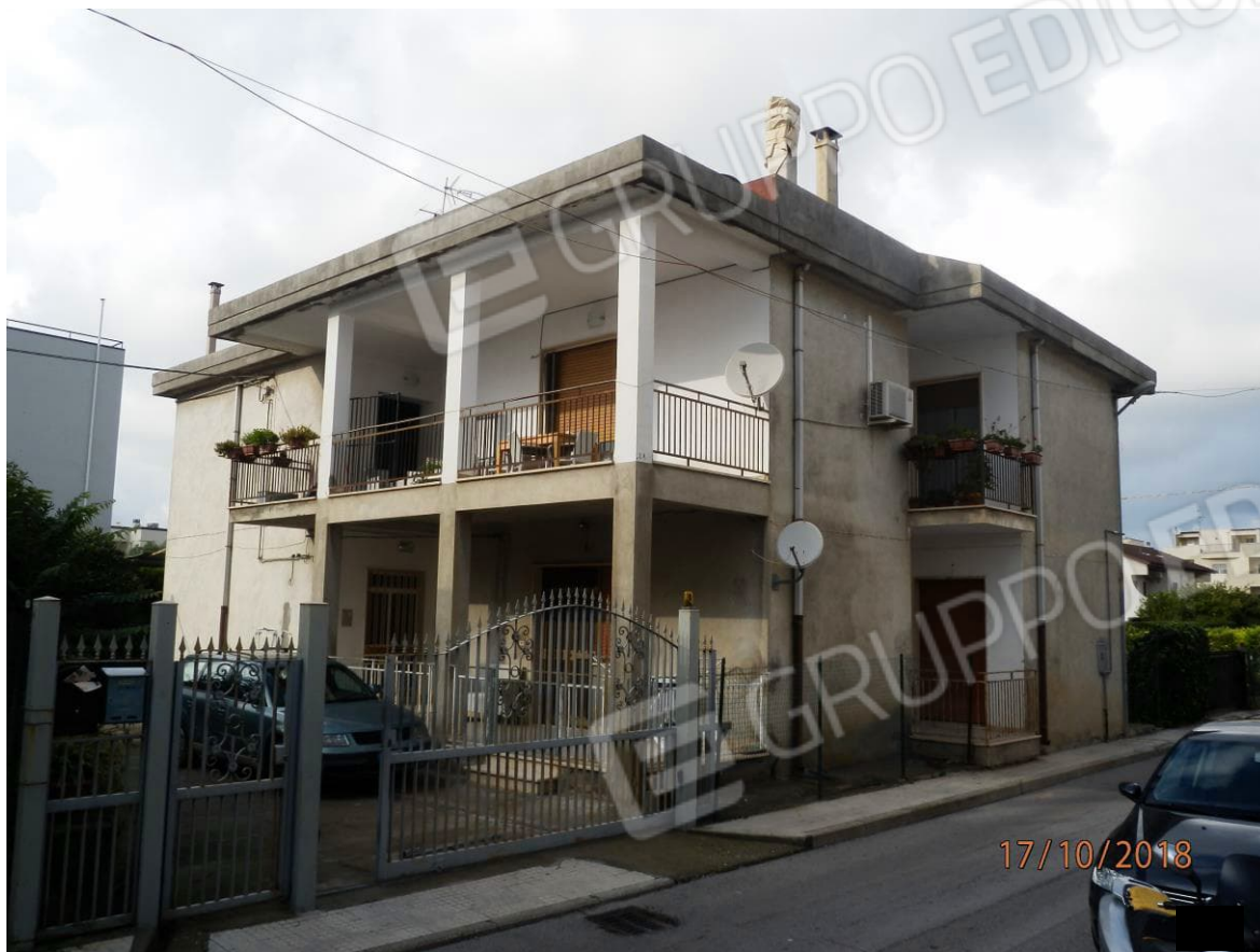
Foto 1 - vista della palazzina di via Pascoli n.39
