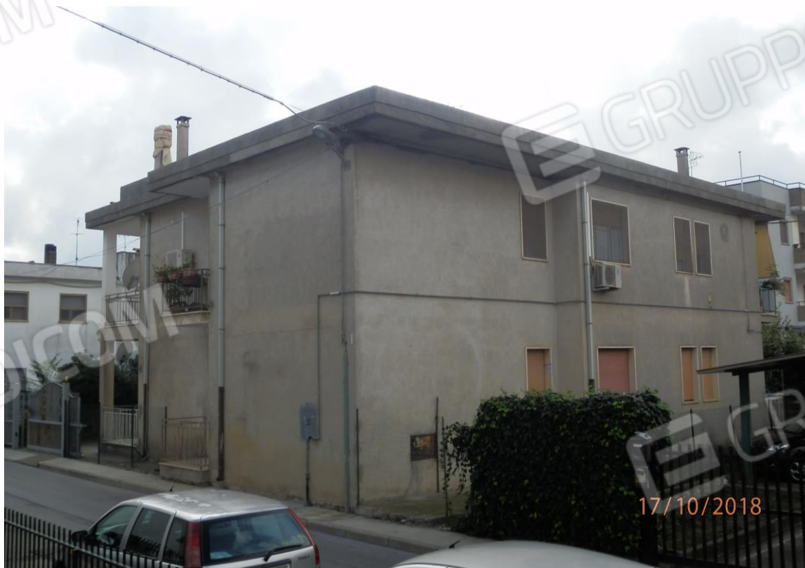
Foto 2 - vista della palazzina di via Pascoli n.39
