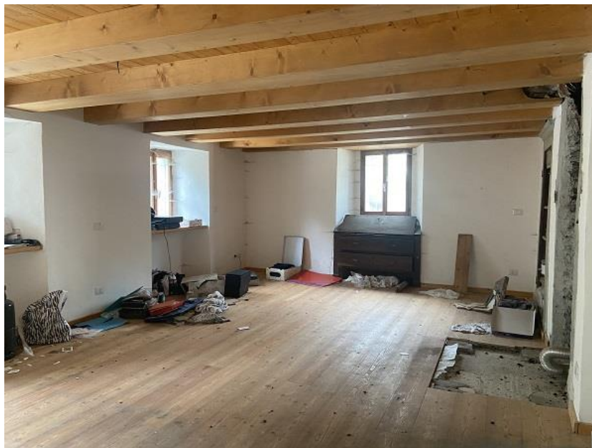
Foto 9: Prima parte di appartamento – Cucina / Pranzo.
