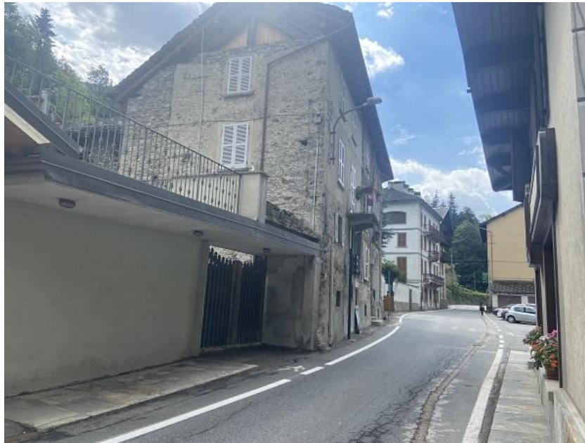
Foto 2: Prospetto sud/ovest visto da corso Umberto I.
