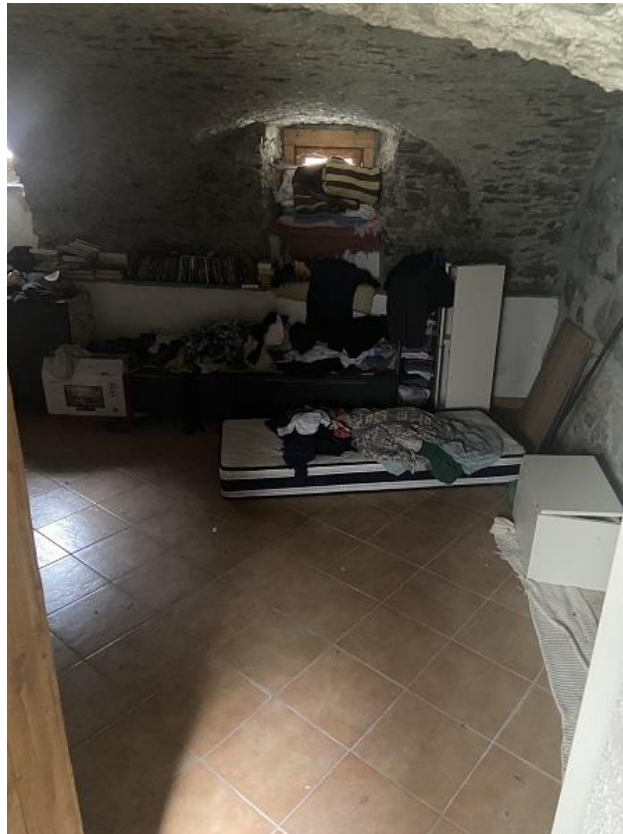
Foto 16: : Prima parte di appartamento – Cantina.
