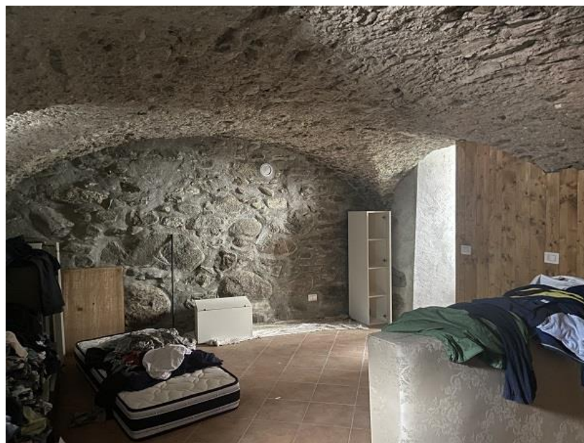
Foto 17: Prima parte di appartamento – Cantina.
