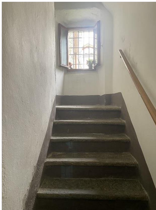
Foto 31: Scala comune che conduce al primo piano.
