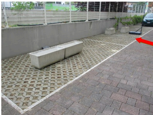
2 – Prospetto esterno – sub.18 – p.terra
