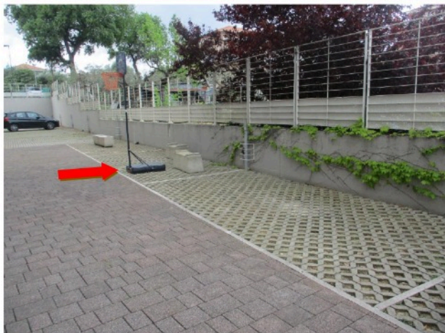
3 – Prospetto esterno – sub.18 – p.terra
