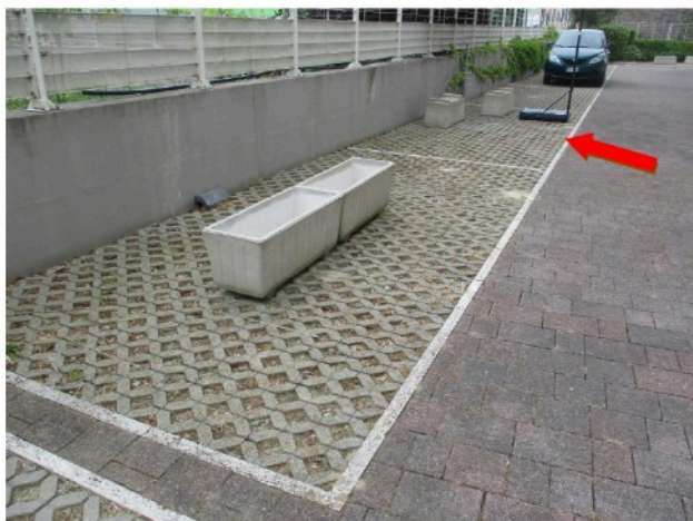
1 – Prospetto esterno – sub.18 – p.terra
