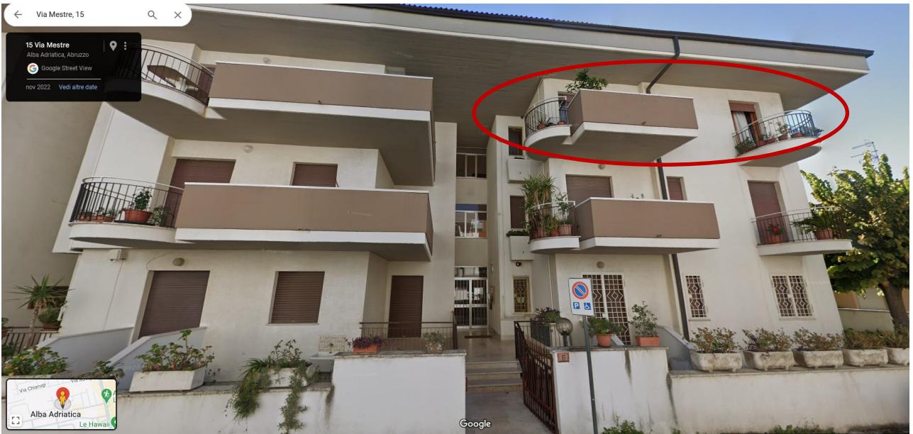
Inquadramento esterno individuazione/collocazione unità immobiliare Vista esterna frontale
