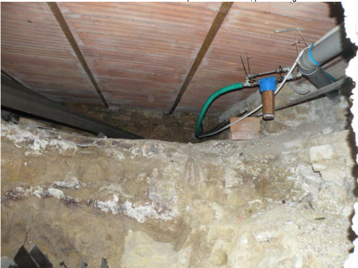
FOTO N°28: Vista interna della cantina al piano seminterrato, particolare grotta.
