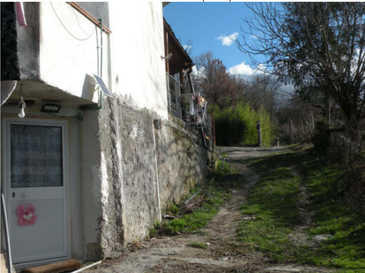
FOTO N°6: Vista esterna della corte comune (Sub 12)/3 di accesso alla cantina.
