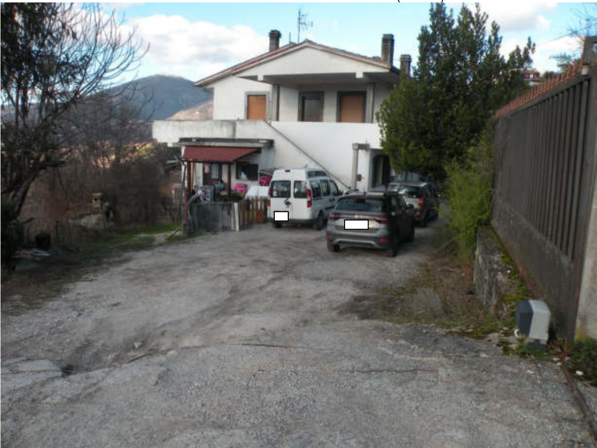
FOTO N°4: Vista esterna della corte comune (Sub 12)/1.
