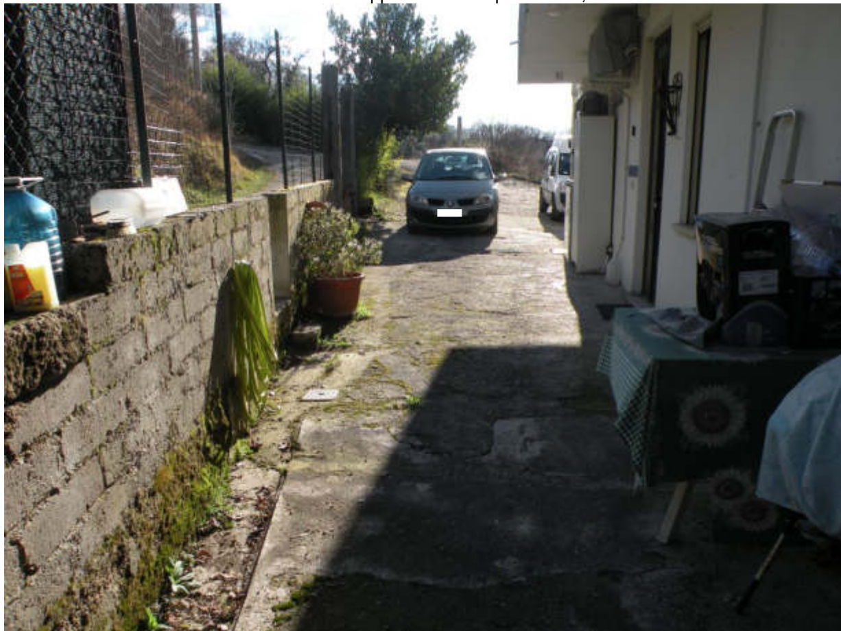
FOTO N°7: Vista esterna dell'appartamento al piano terra, corte esclusiva/1.
