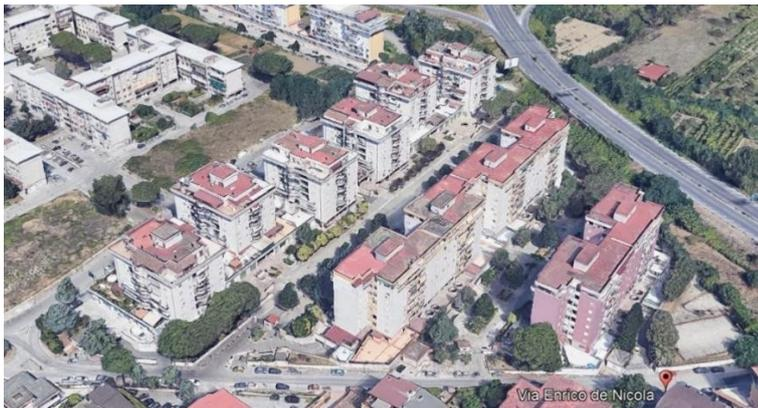
Sono stati edificati con struttura portante costituita da un telaio in travi e pilastri in calcestruzzo armato, con solai latero-cementizi, con le murature di tompagnatura, sia interne che esterne realizzate in mattoni forati di laterizio con finitura esterna in intonaco civile bicolore (giallo e grigio).
