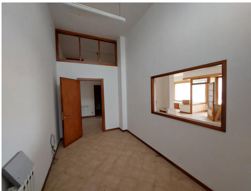
Foto n.108: Particolare della sala chirurgica (BENE N). Notare l'elemento radiante dell'impianto di riscaldamento in alluminio.
