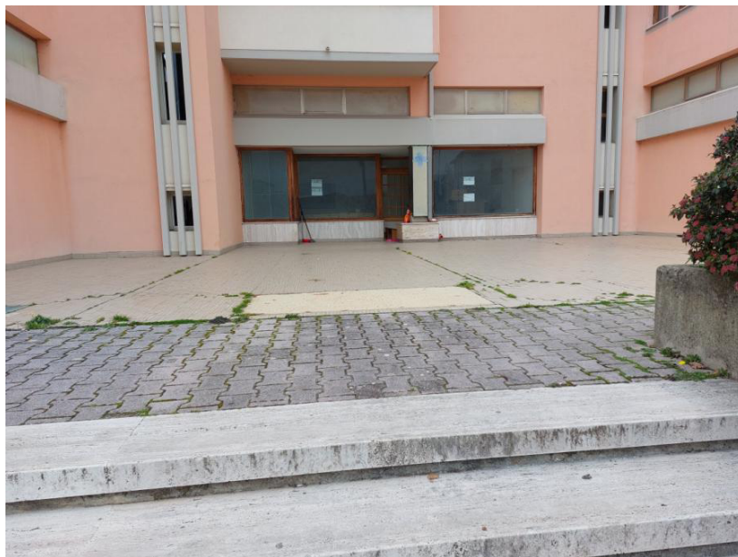
Foto n.102: Altro particolare del fabbricato residenziale (BENE N). Notare la corte comune completamente lastricata e la struttura portante in cemento armato con tamponatura esterna intonacata e tinteggiata.
