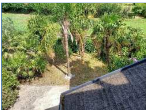
Fotografia 37 – Area scoperta comune
