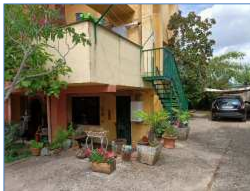
Fotografia 10 – Scala ingresso secondario
