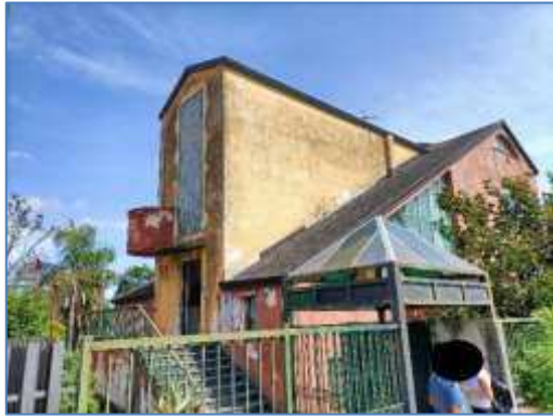
Fotografia 1 – Prospetto su via Astolfi
