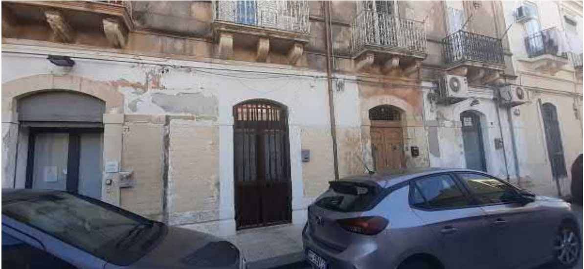
FOTO N. 1 – PROSPETTO SU VIA ISONZO
