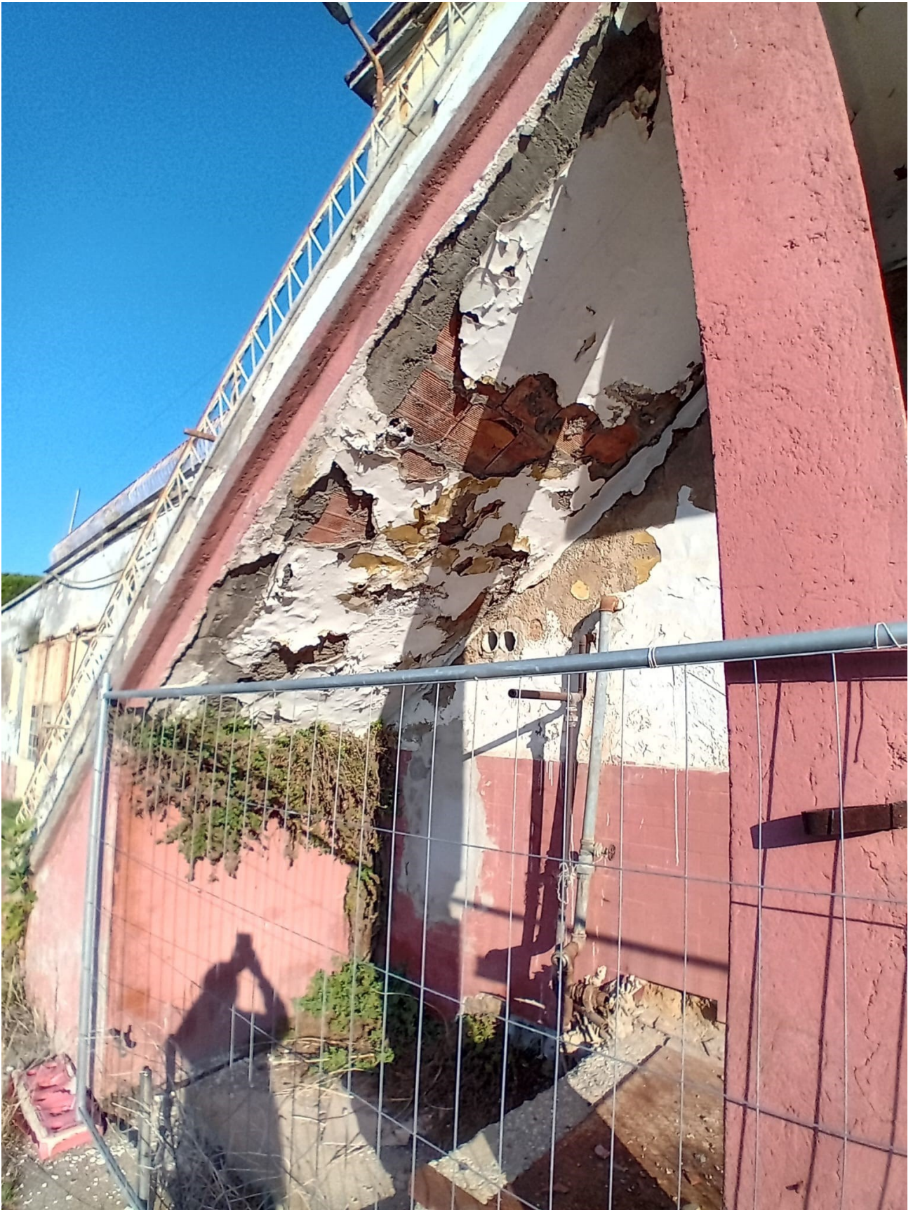
Rampa scala che dà accesso all'immobile
