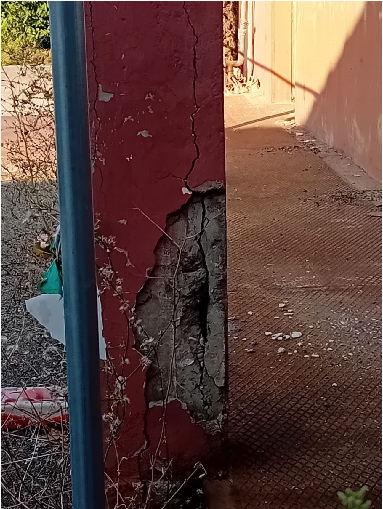
Colonna a sostegno del balcone dalla quale si accede all'immobile
