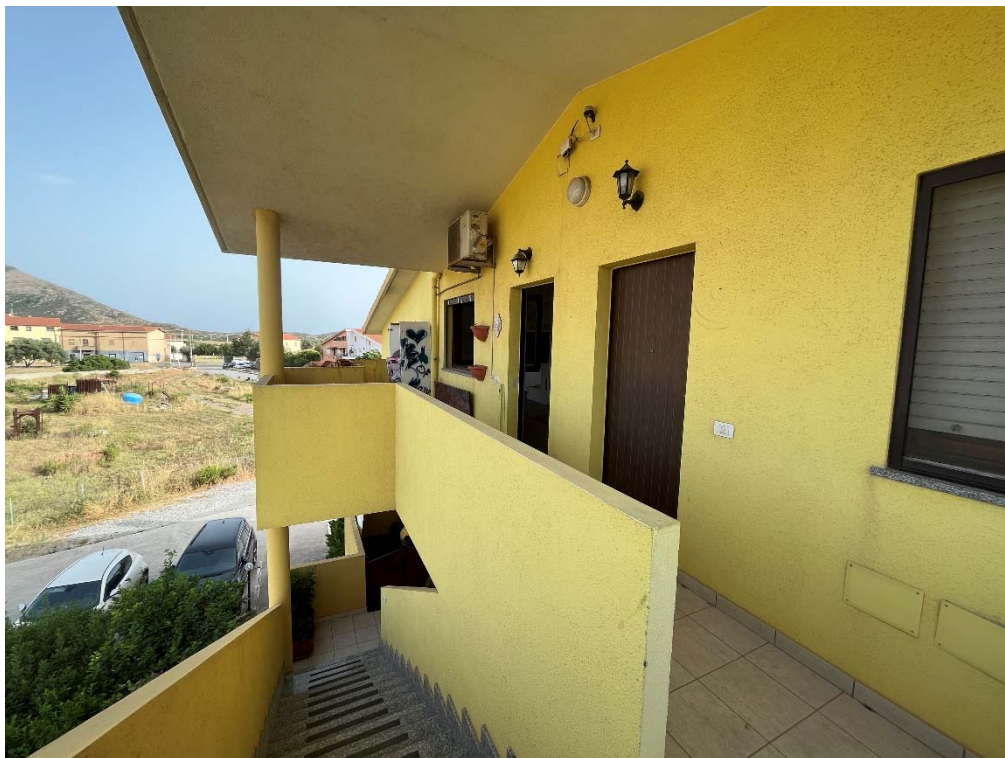
Foto n°6 – Veduta dell'ingresso dal vano scala.
