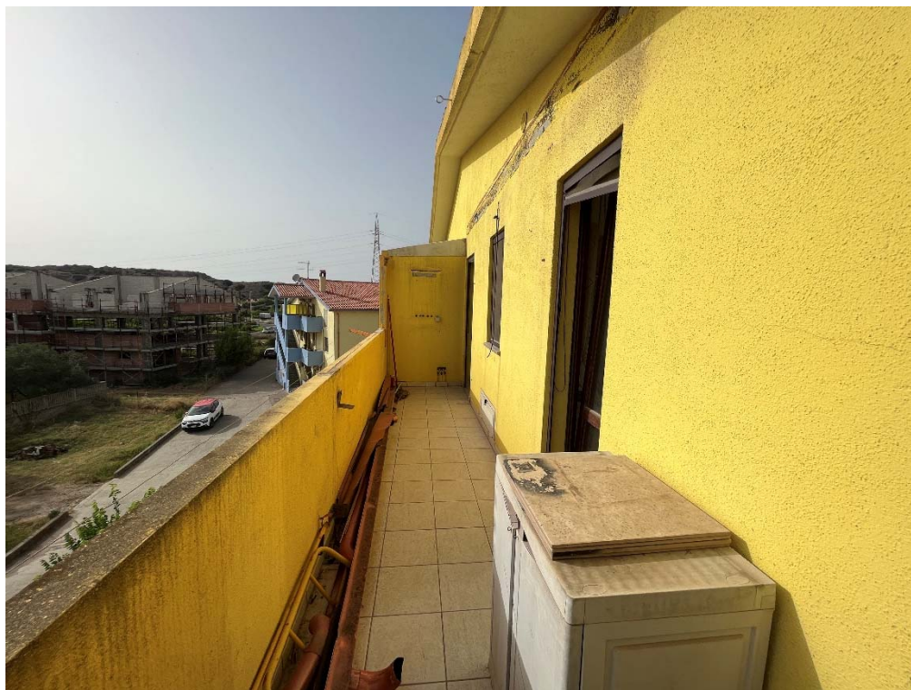
Foto n°9 – Veduta del balcone sul retro.
