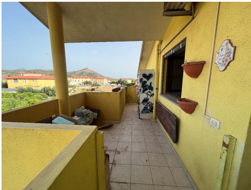
Foto n°7 – Veduta del balcone frontale.
