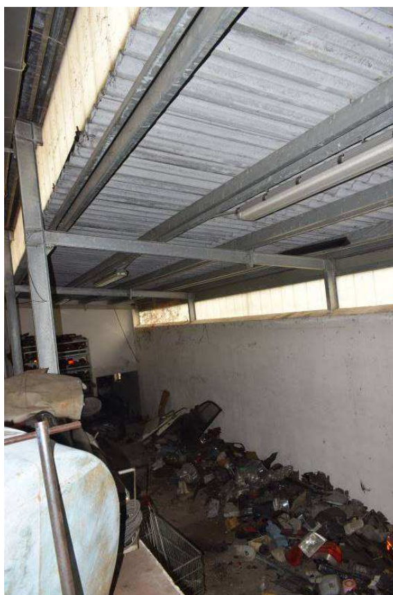
LA PORZIONE "RIBASSATA" DEL CAPANNONE
