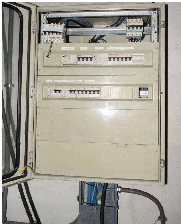
DETTAGLIO QUADRO ELETTRICO
