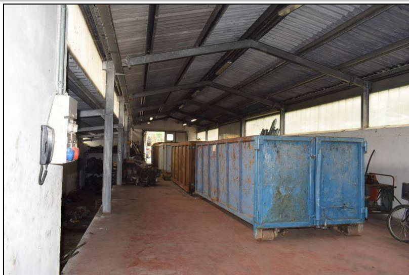
VISTA INTERNA DEL CAPANNONE
