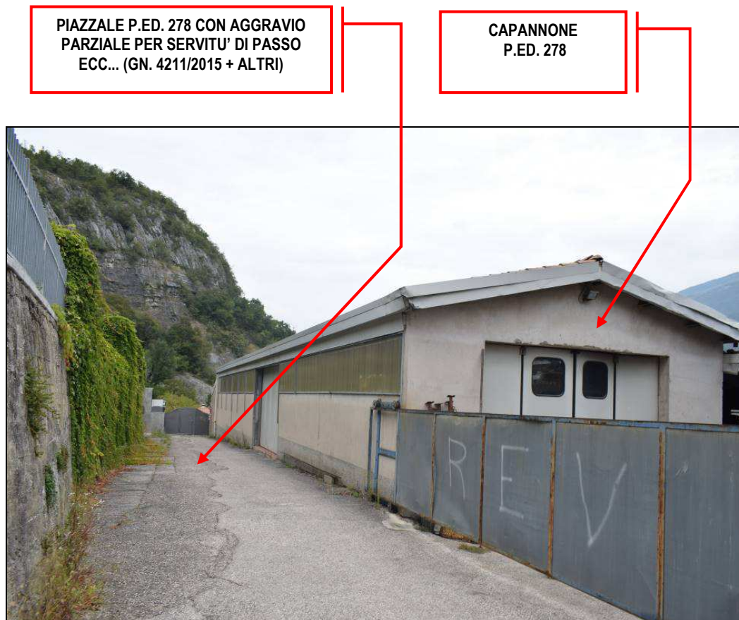
FRONTE SUD E PIAZZALE OVEST DEL CAPANNONE P.ED. 278
