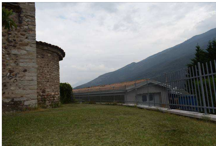
VISTA DEL CAPANNONE DALLA ZONA DELLA CHIESA
