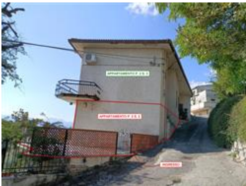
Vista esterna del fabbricato con individuazione dell'appartamento p.lla 2 sub. 2
