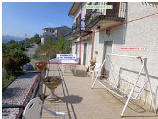
Vista esterna dell'appartamento dal terrazzo di pertinenza p.lla 2 sub. 2
