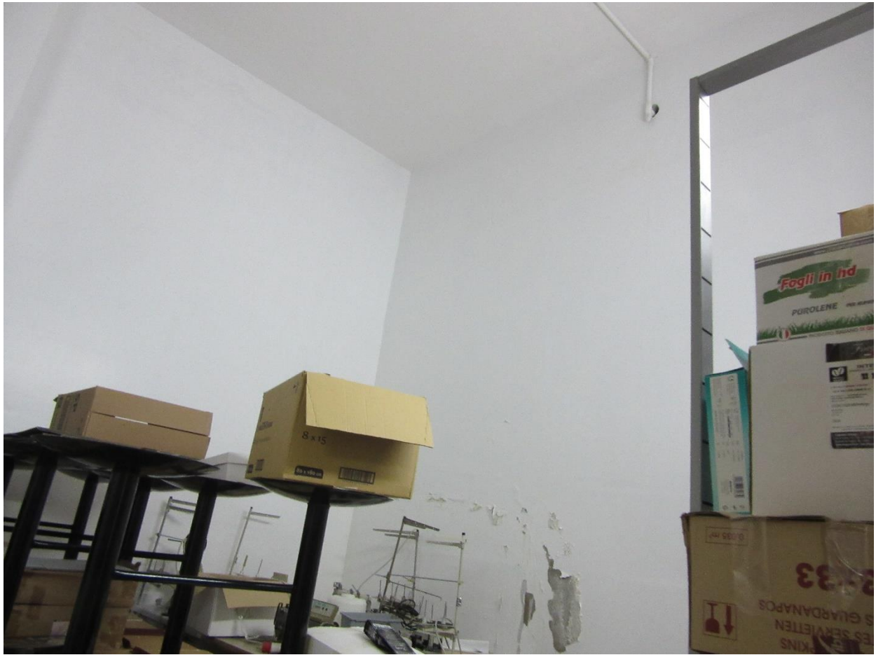
Foto n.9 : vista interna (S5).
