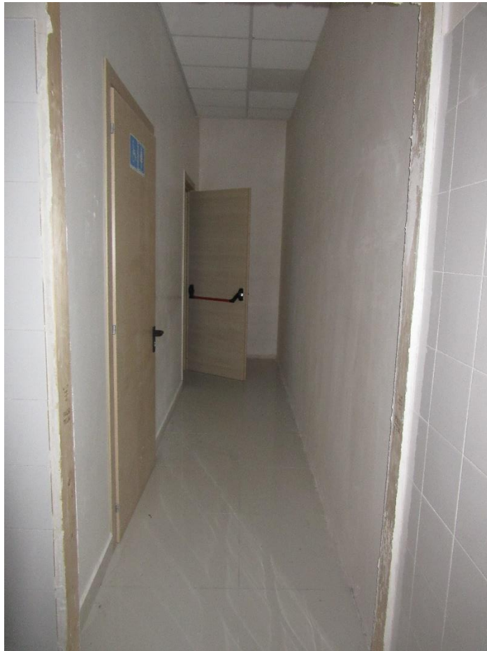
Foto n.21 : vista interna (wc 2).
