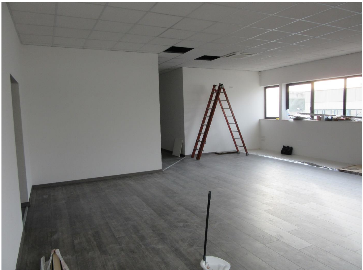
Foto n.38 : vista interna (P2).
