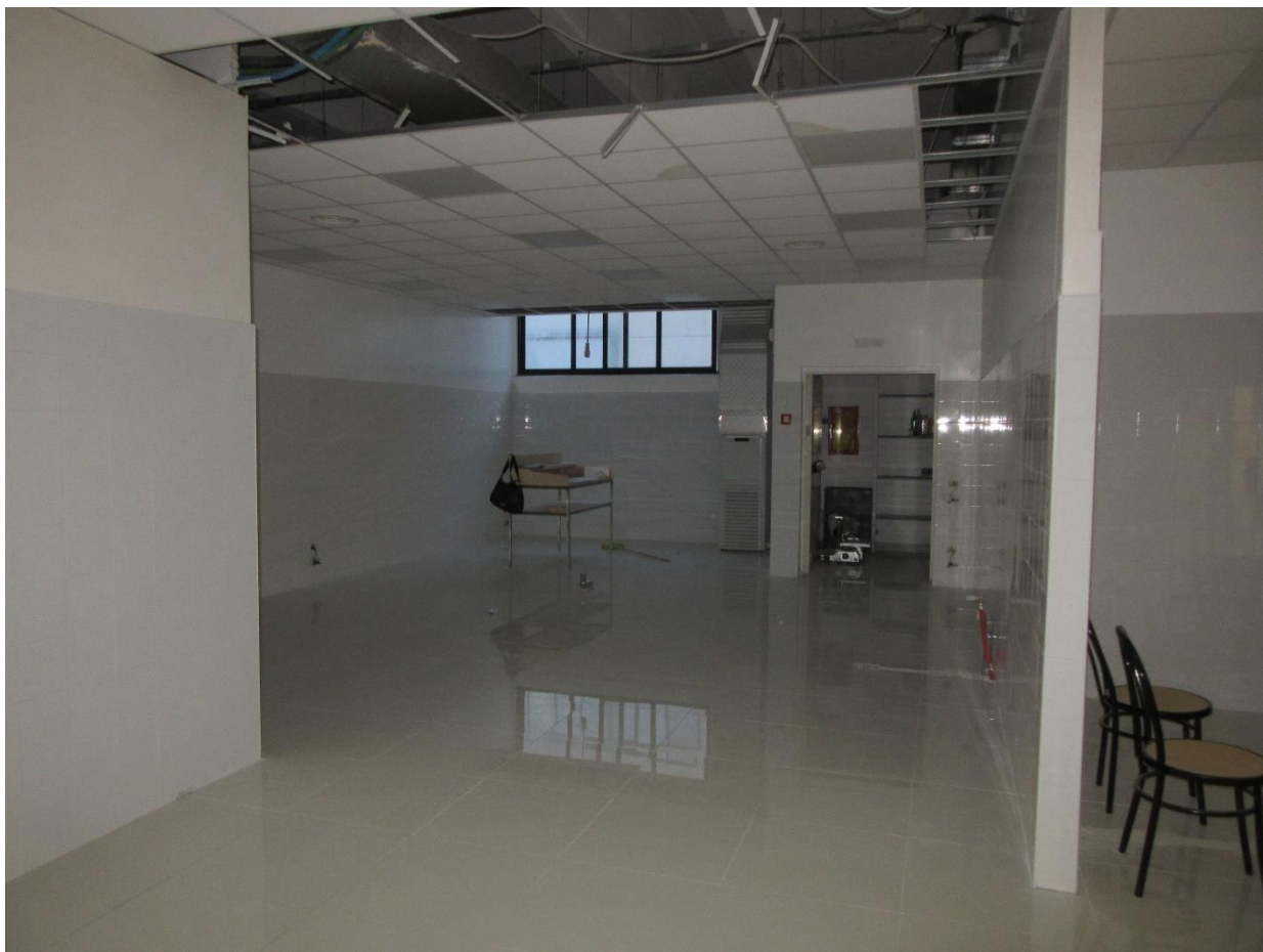
Foto n.19 : vista interna (T1).
