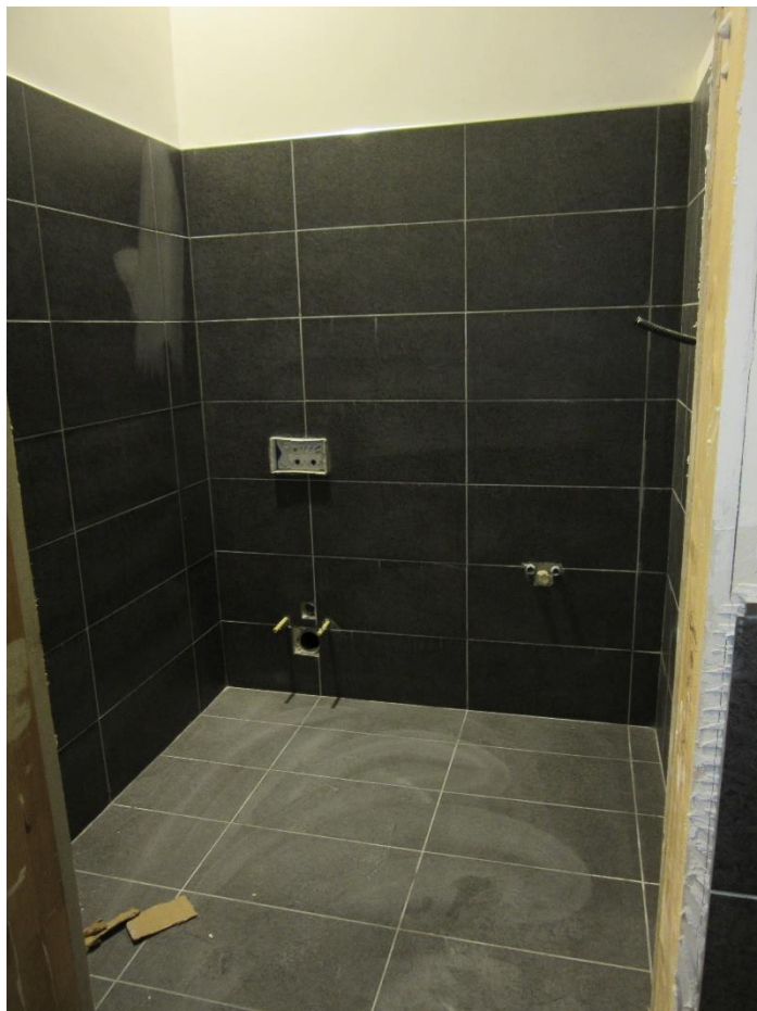
Foto n.34 : vista interna (WC3).
