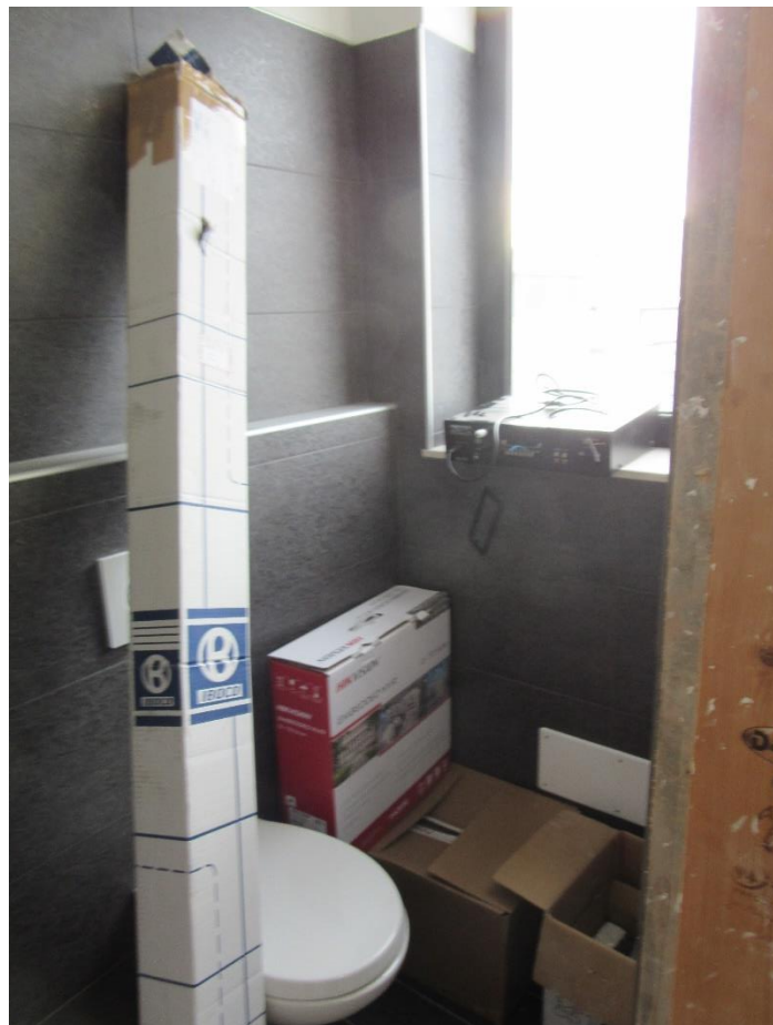
Foto n.42 : vista interna (WC2).
