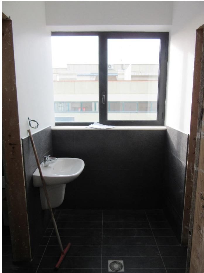
Foto n.41 : vista interna (WC2).
