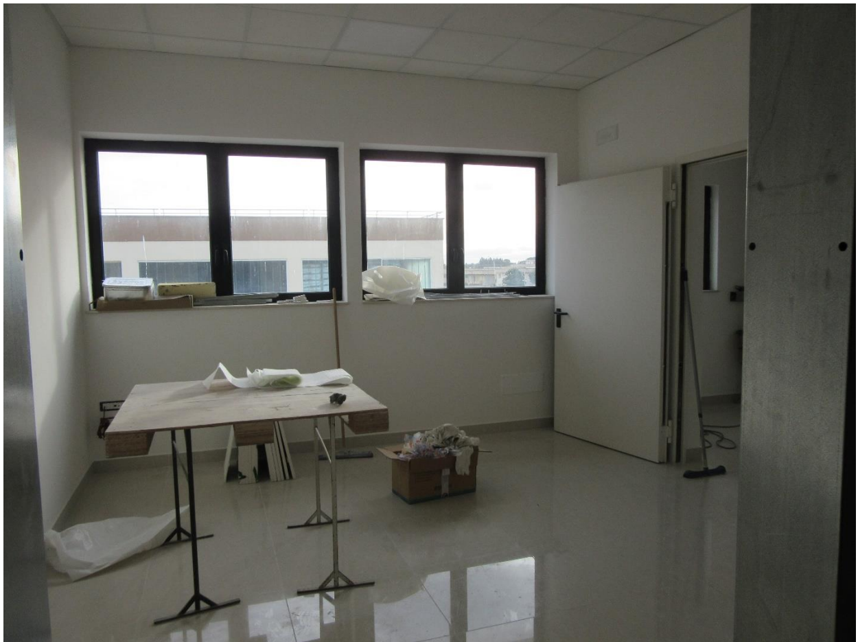
Foto n.45 : vista interna (P4).
