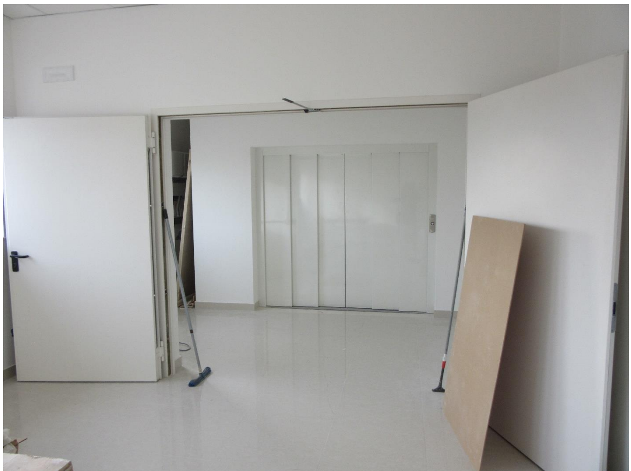
Foto n.46 : vista interna (P3).
