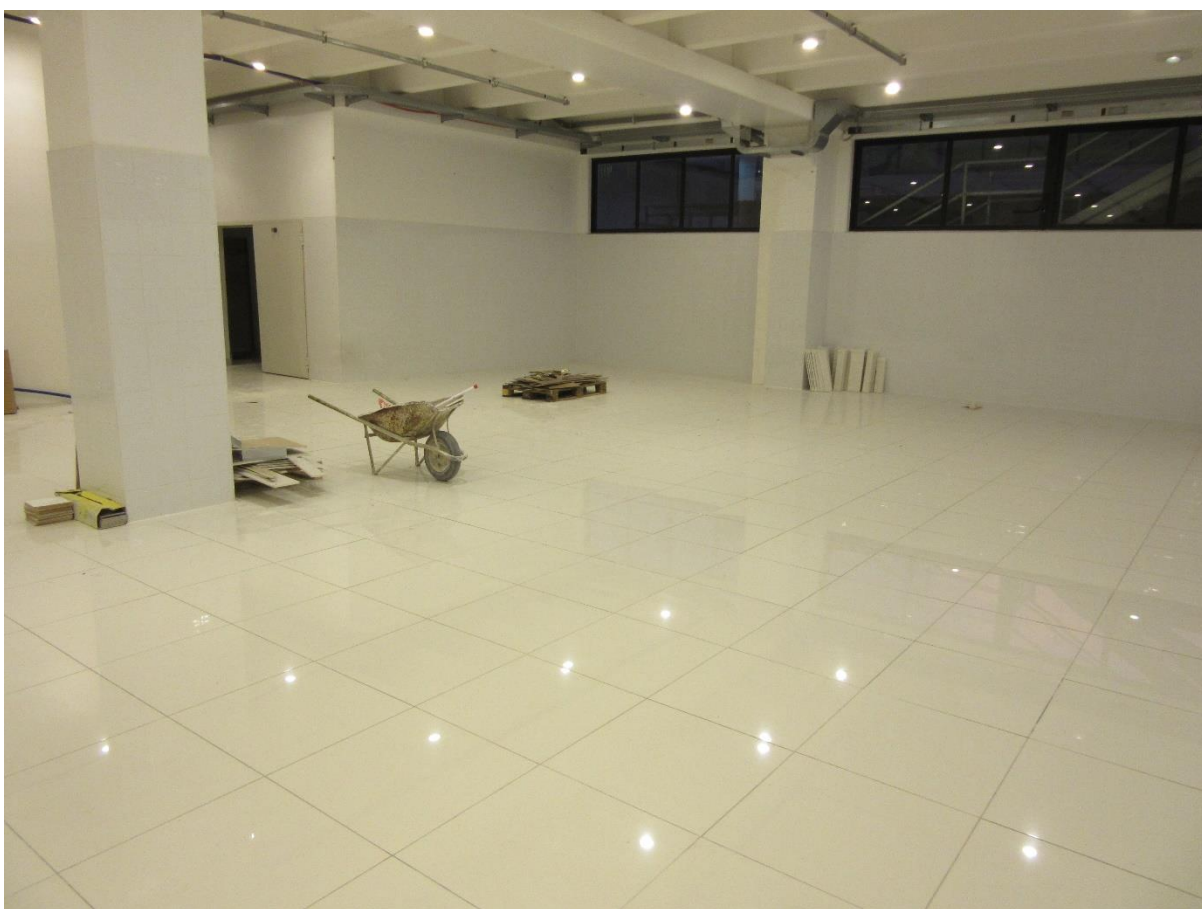
Foto n.28 : vista interna (T3).
