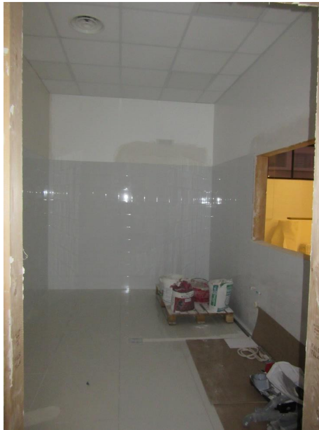
Foto n.25 : vista interna (T2).
