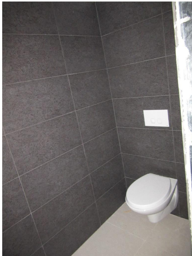
Foto n.50 : vista interna (WC1).
