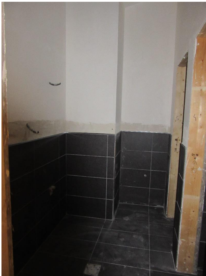
Foto n.30 : vista interna (WC 3).
