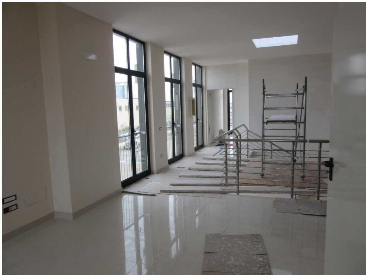
Foto n.51 : vista interna (P12).
