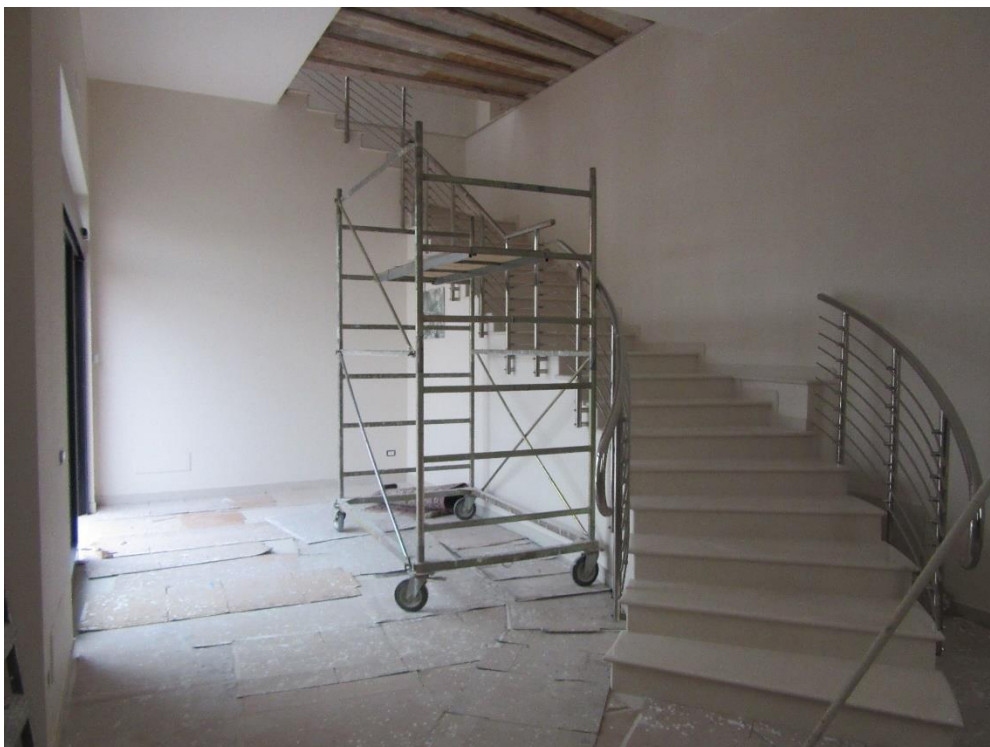
Foto n.36 : vista scala interna.
