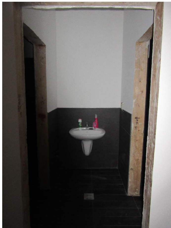
Foto n.48 : vista interna (WC1).
