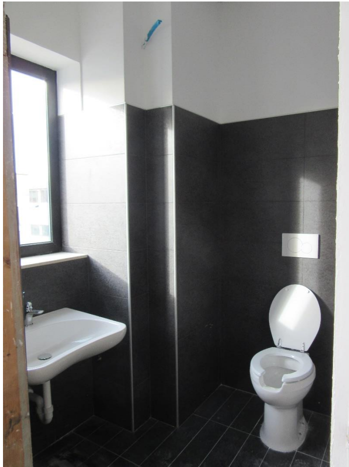
Foto n.43 : vista interna (WC2).
