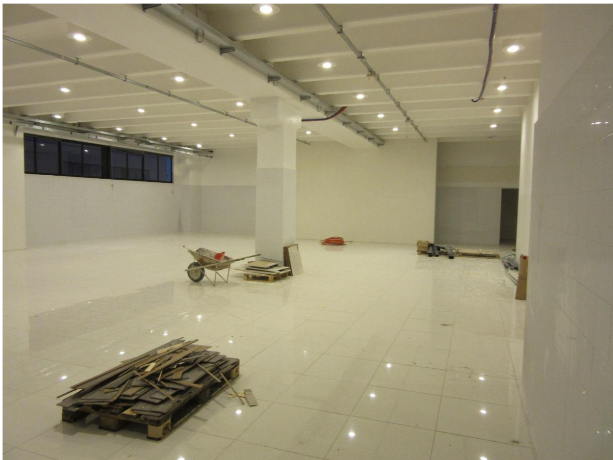
Foto n.27 : vista interna (T3).
