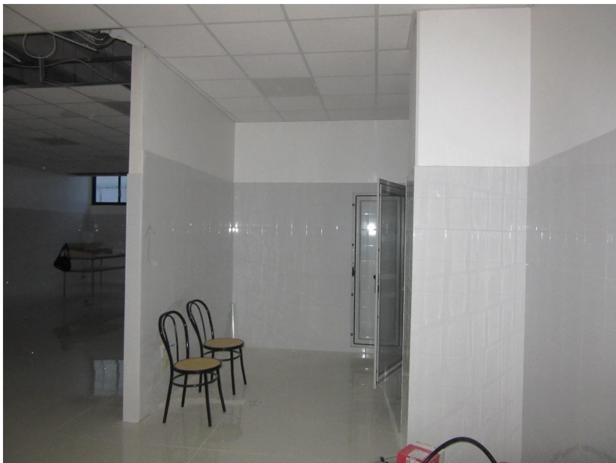
Foto n.20 : vista interna (T1).
