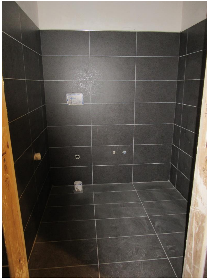
Foto n.33 : vista interna (WC3).
