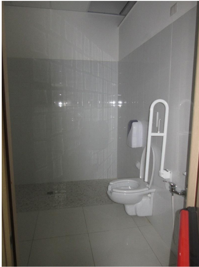
Foto n.23 : vista interna (wc 2).
