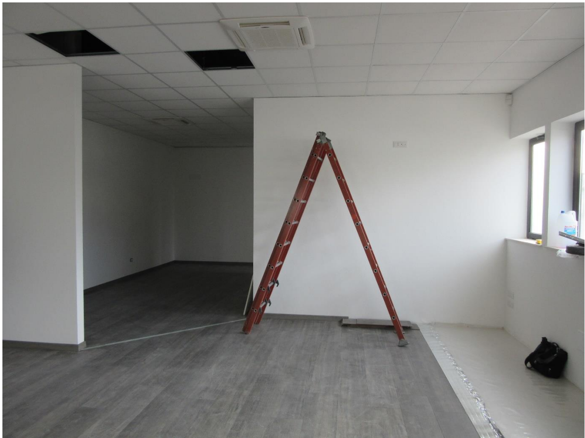
Foto n.39 : vista interna (P2).
