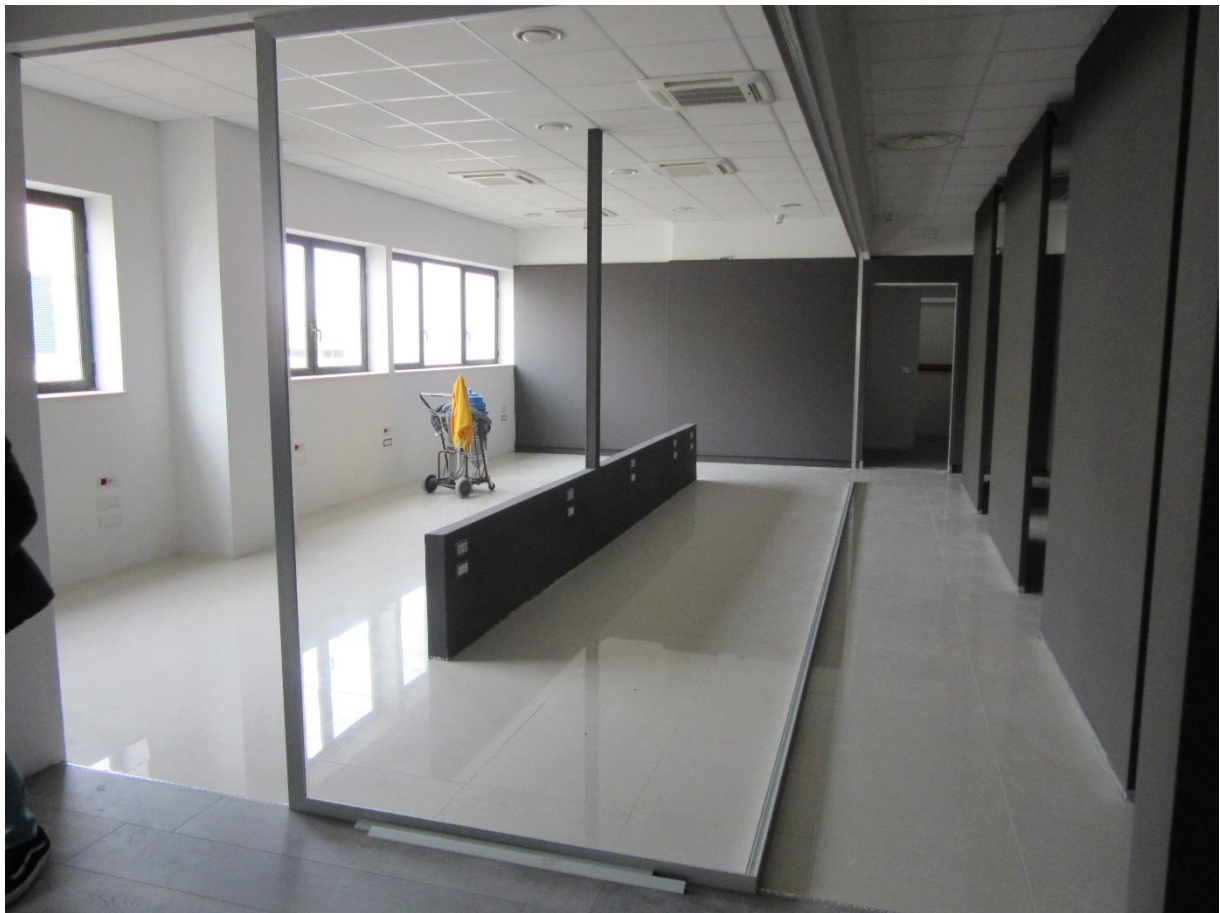
Foto n.37 : vista interna (P6).
