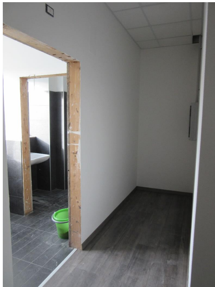
Foto n.40 : vista interna (WC2).
