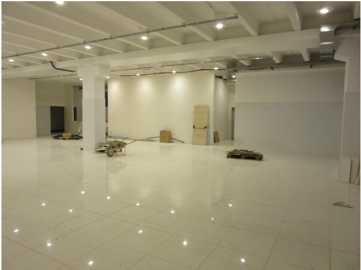
Foto n.26 : vista interna (T3).
