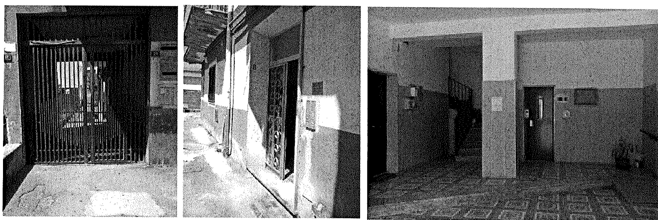
Figura 3 – Da sinistra a destra: Ingresso principale, ingresso scala B, atrio con vano scala e ascensore
