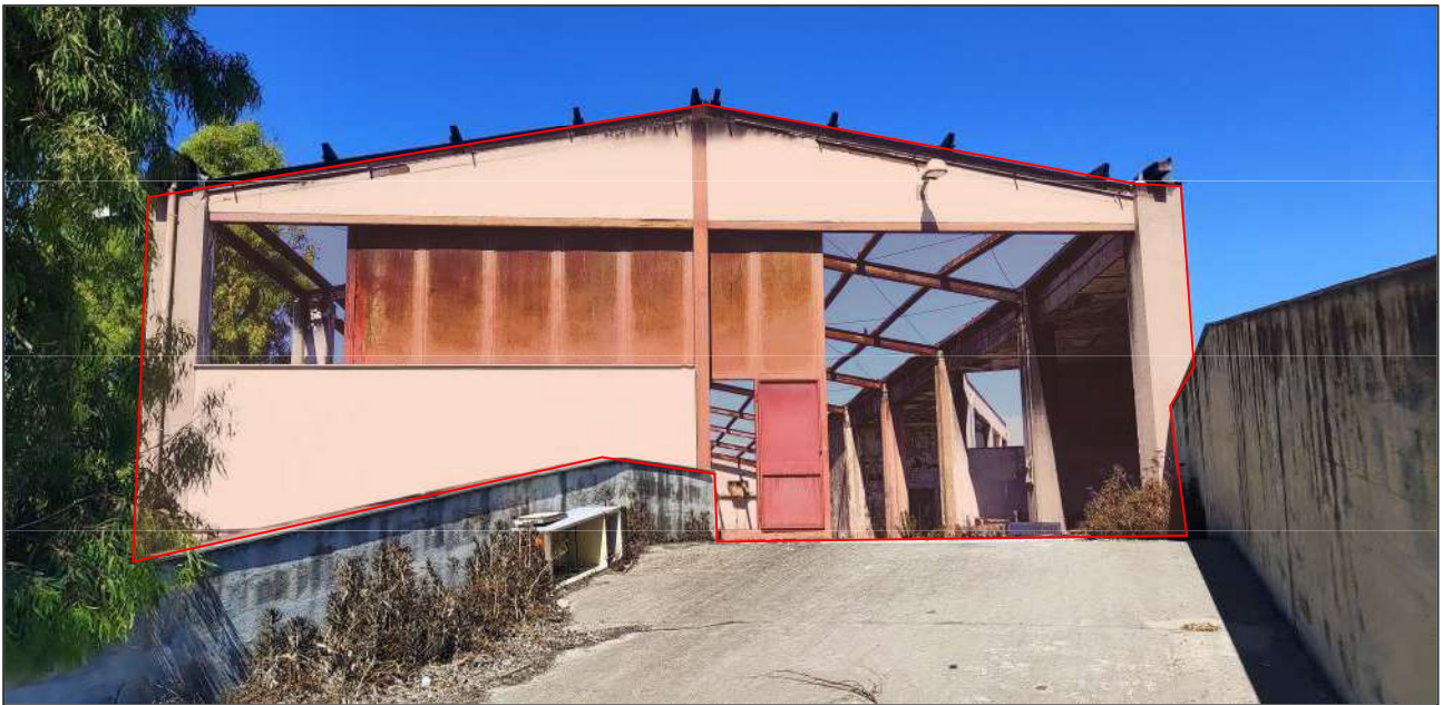
Prospetto ad est. (Corpo A)
