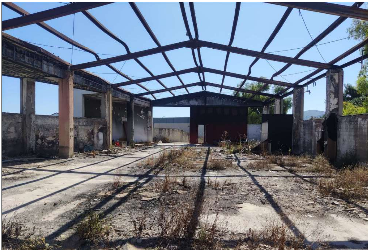
Visione d'insieme guardando verso la rampa di accesso al piano.
