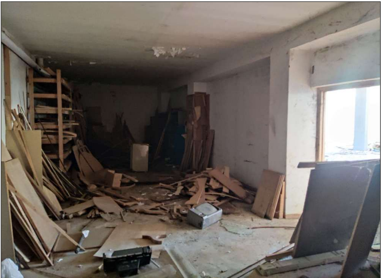
Vano adibito a deposito
