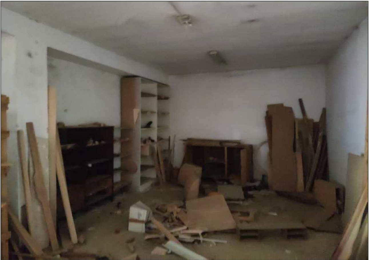
Vano adibito a deposito
