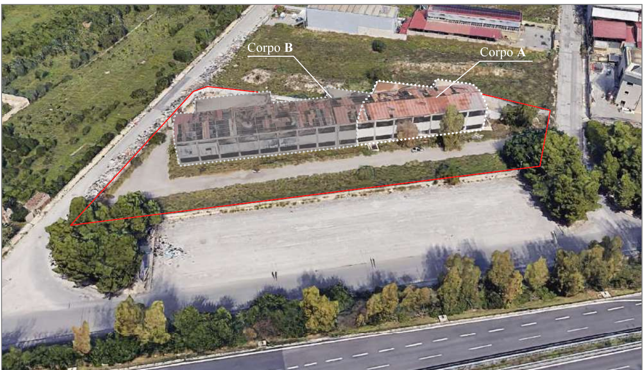
Visioni d'insieme del complesso di Fondo La Rosa. Nella foto sono ancora visibili "tracce" dei pannelli di copertura oggi totalmente assenti.
