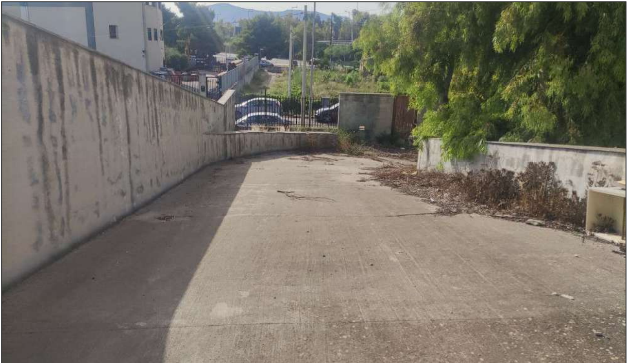
La rampa di accesso al piano
