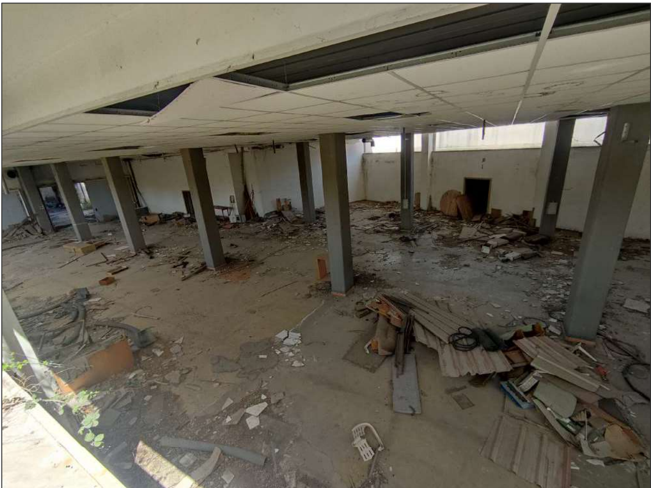
Visione d'insieme del locale pilastrato
