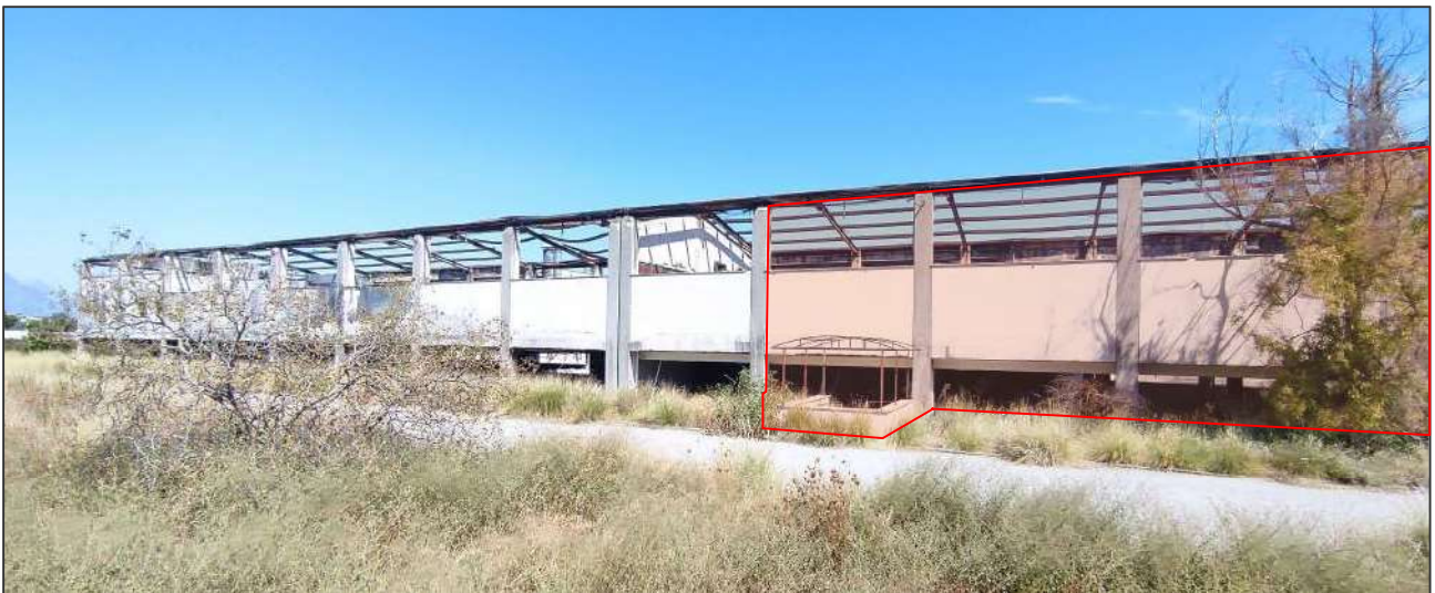
Prospetto a sud. In rosso il Corpo A.
