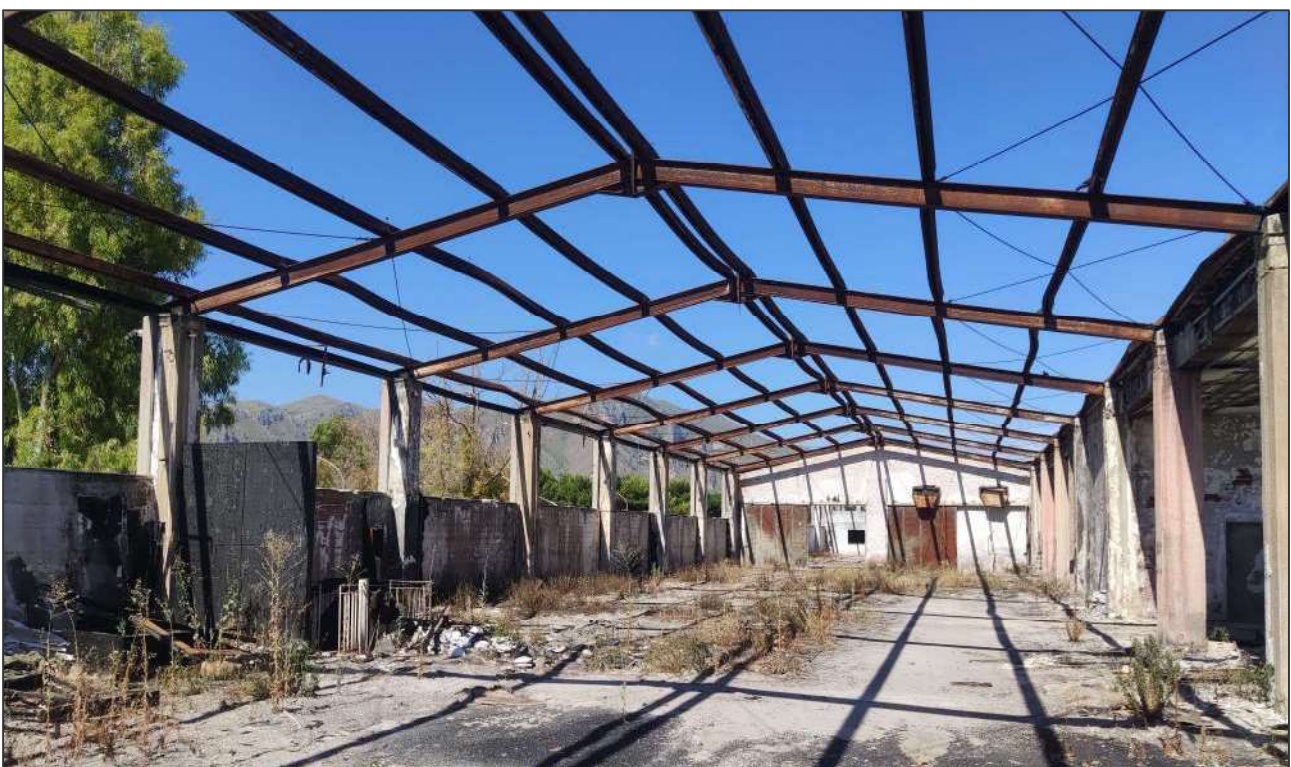
Visione d'insieme guardando verso il Corpo B
