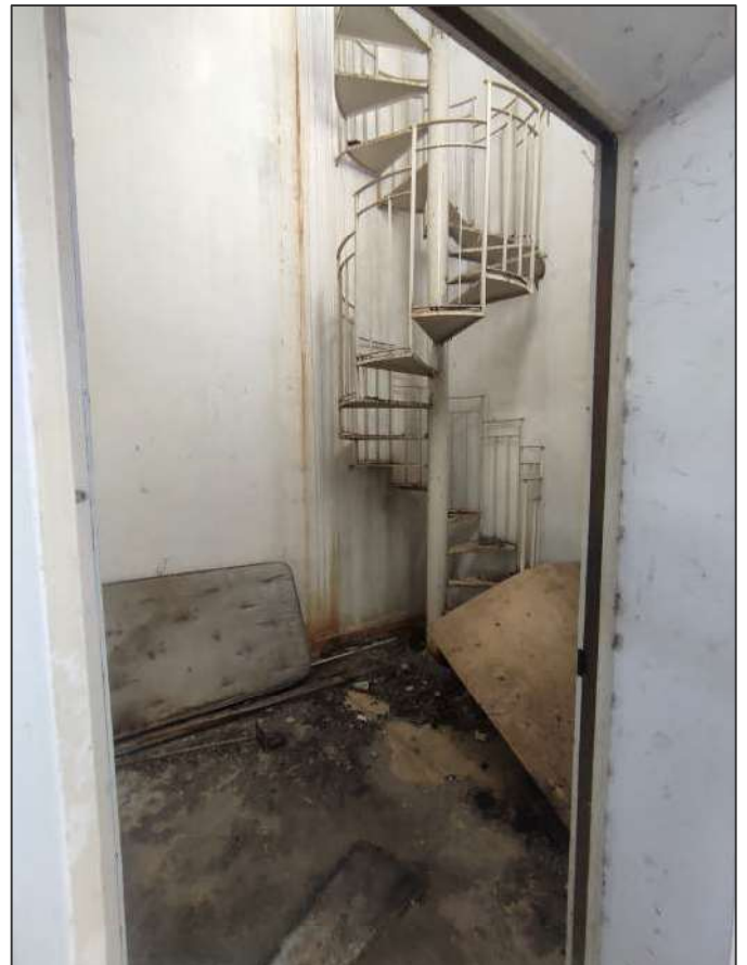
Scala a chiocciola di collegamento con il piano soprastante posta all'interno dell'ex vano corsa del montacarichi
