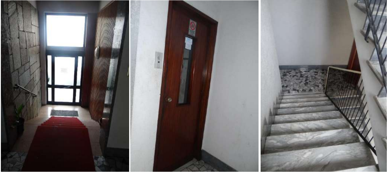
Fotografie 4, 5 e 6 : immagini del vano scala condominiale
