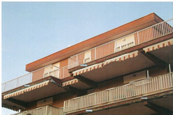
Foto n. 8 Lavori di ripristino frontalino balconi.
