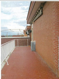
Foto n.22 Terrazza, lato sinistro dell'appartamento.
