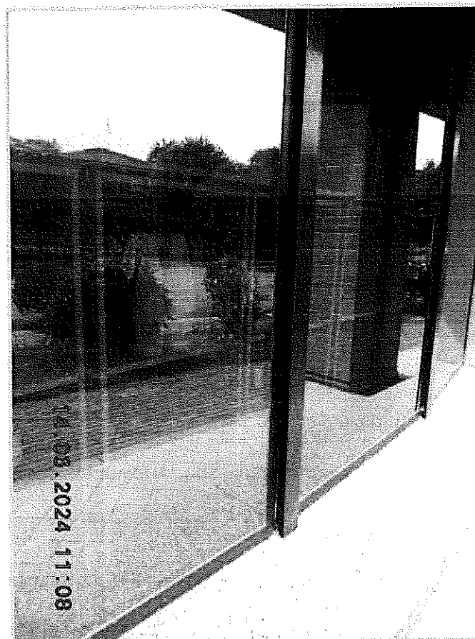
FOTO 04 TELAI ESTERNI VETRINE CHE RICHIEDONO MANUTENZIONE
