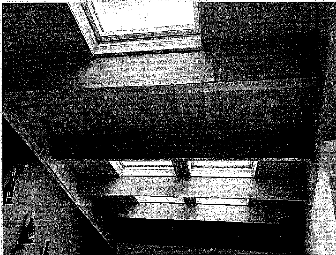
FOTO 06 ALONI SU TRAVI SOFFITTO CAUSATE DA INFILTRAZIONI
