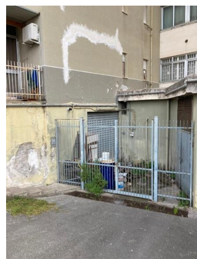
Ingresso carrabile su area condominiale a est
