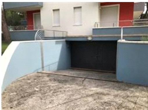
Accesso piano interrato
