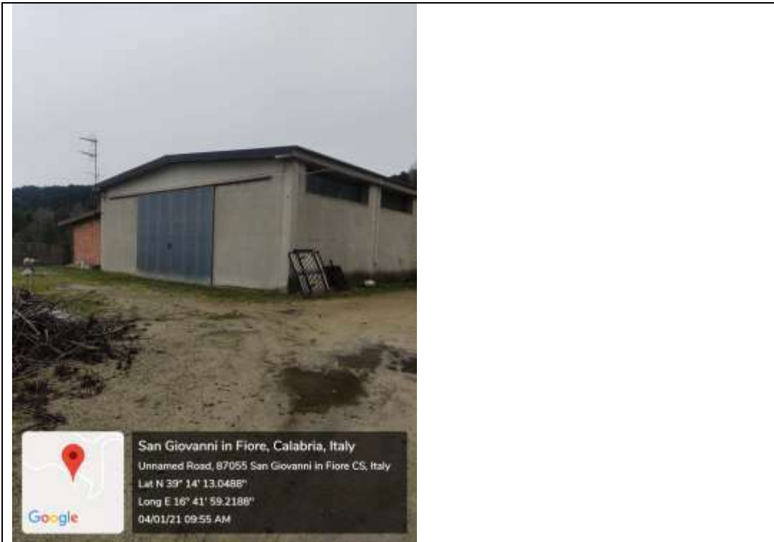
Figura 18 Capannone Industriale sub 3 Lato Sud-Ovest
