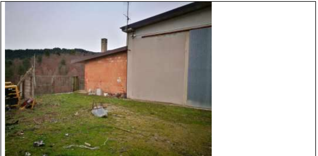
Figura 17 Capannone Industriale sub 3 Lato Sud-Ovest – visibile la costruzione annessa
