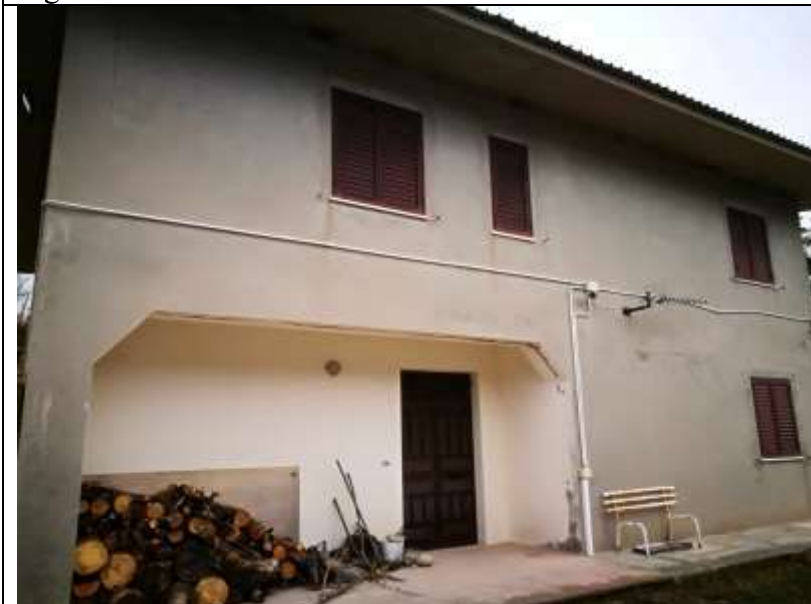
Figura 25 Fabbricato Facciata Nord Est
