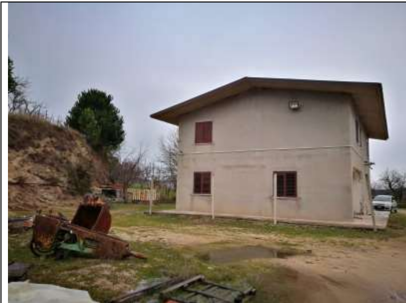
Figura 26 Fabbricato Facciata Sud Ovest
