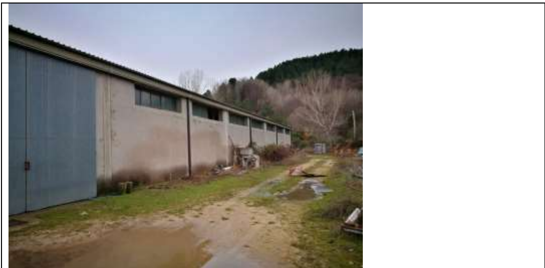
Figura 16 Capannone Industriale sub 3 Lato Nord-Ovest
