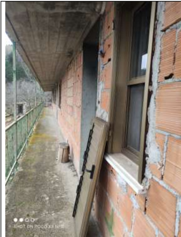
Figura 20 Edificio annesso al Capannone Industriale Lato Sud-Est
