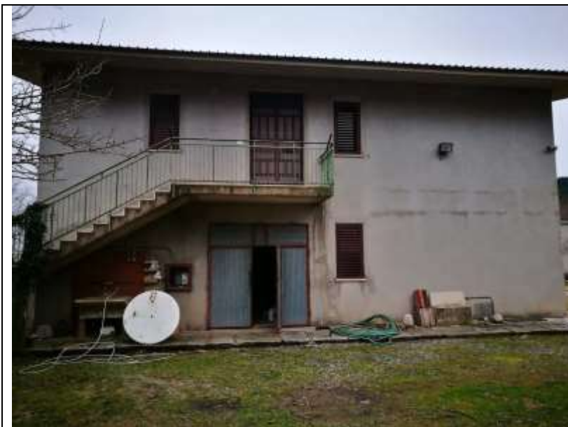
Figura 24 Fabbricato Facciata Nord Ovest
