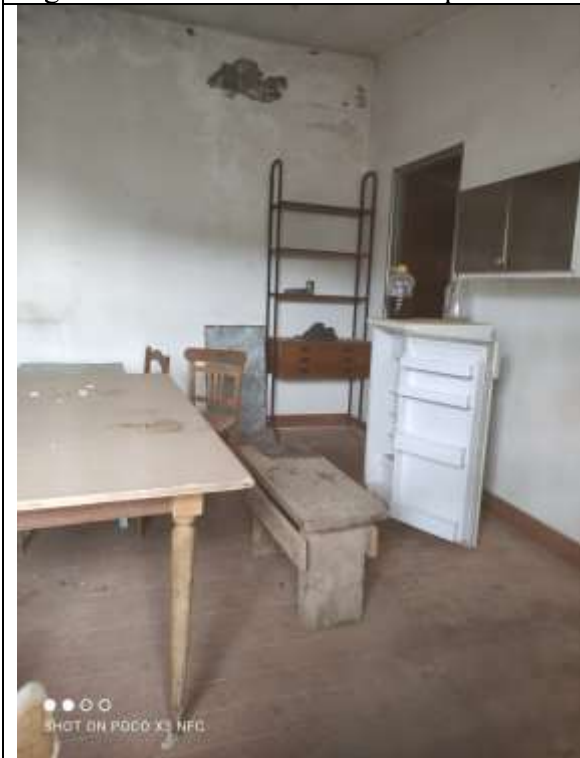
Figura 21 Edificio annesso al Capannone Industriale Lato Sud-Est
