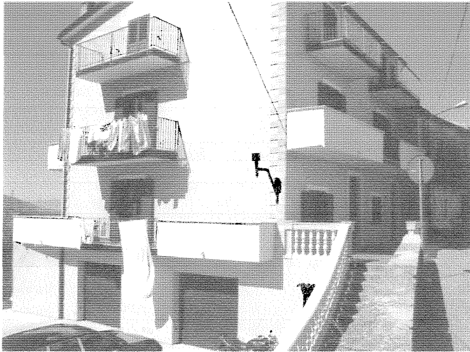
Foto 1: Vista lato Sud
