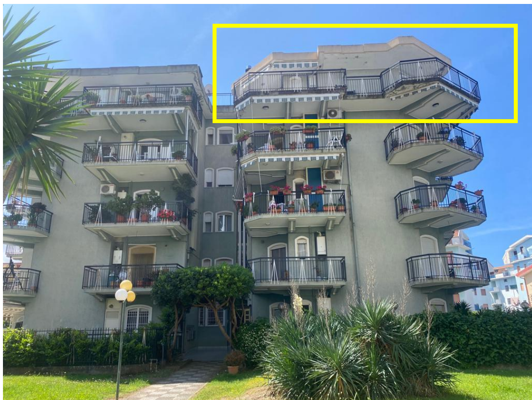
Foto 4: particolare facciata fabbricato – prospetto nord
