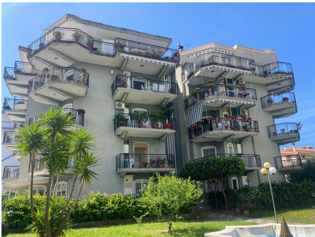
Foto 3: particolare facciata fabbricato – prospetto nord
