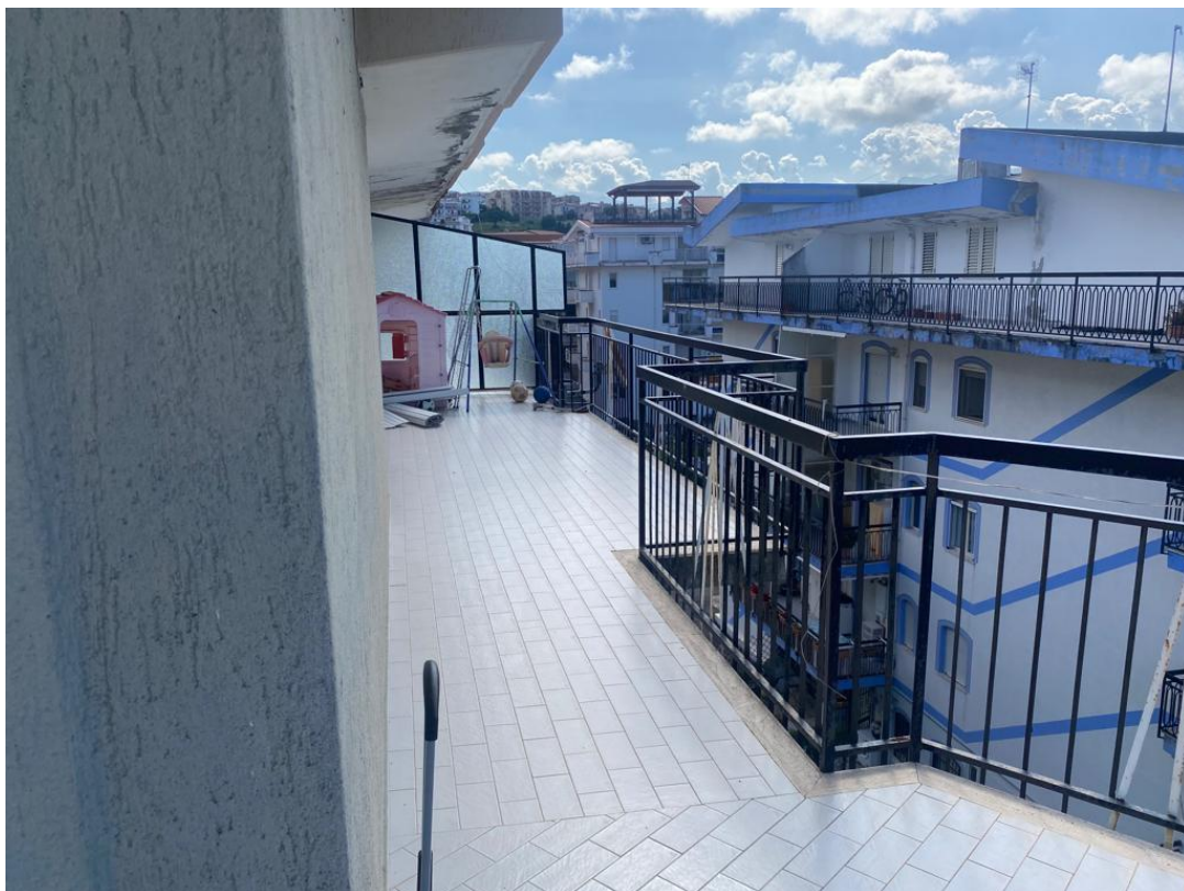
Foto 17: vista esterna sub 12 - particolare balcone
