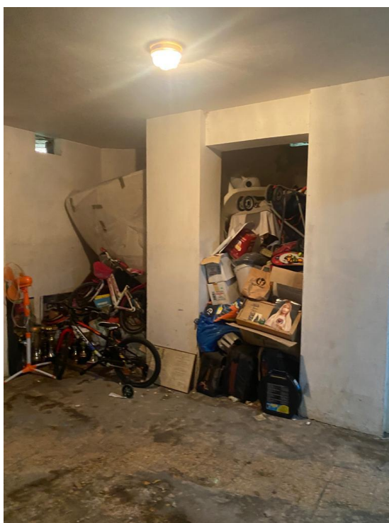
Foto 22: vista interna sub. 20 – particolare magazzino
