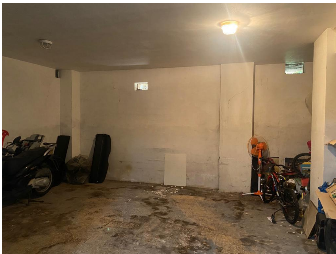
Foto 20: vista interna sub. 20-21 – particolare magazzino
