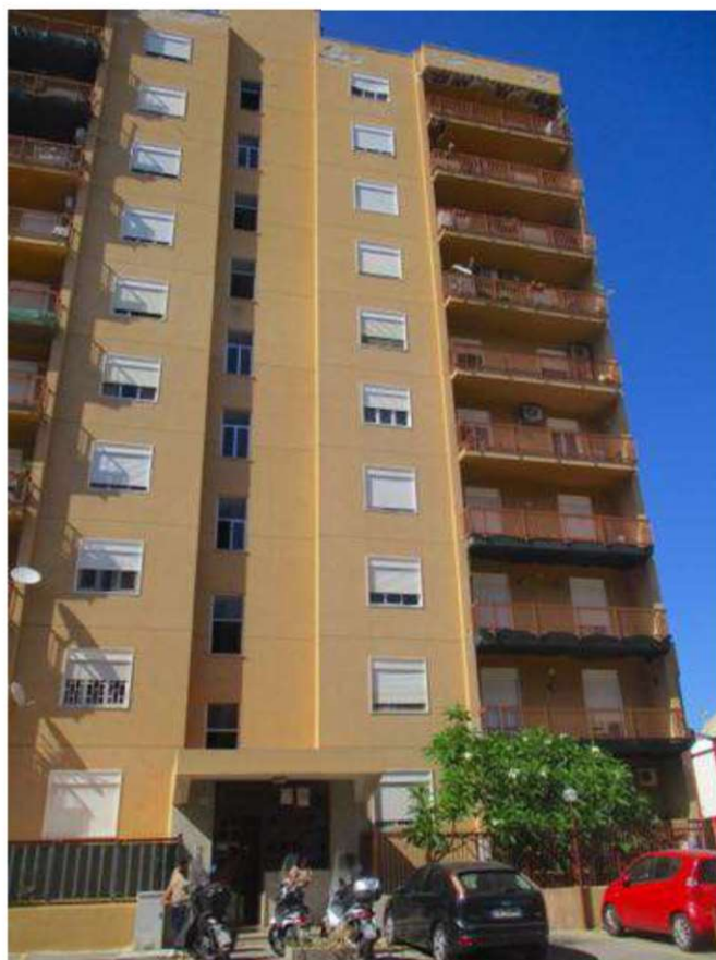
Foto 1- vista dell'edificio sito in Palermo corso dei Mille 1066
