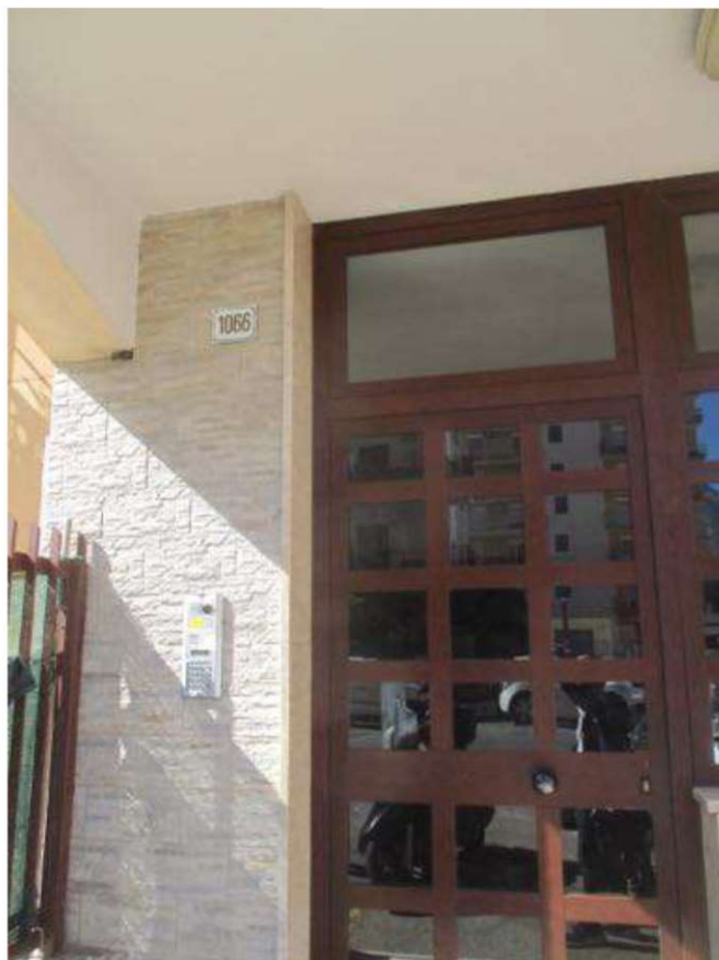
Foto 2- vista dell'edificio sito in Palermo corso dei Mille 1066
