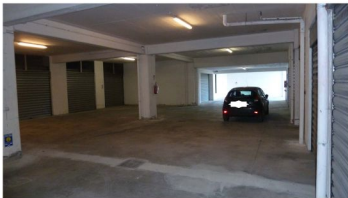
Foto 15 – Ancora particolare verso l'uscita
