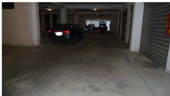
Foto 14 – l'area di manovra che prosegue verso l'uscita
