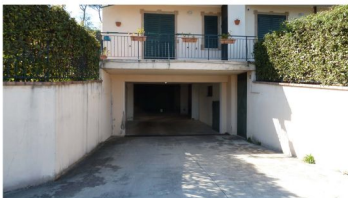
Foto 16 – L'uscita carrabile del piano Seminterrato
