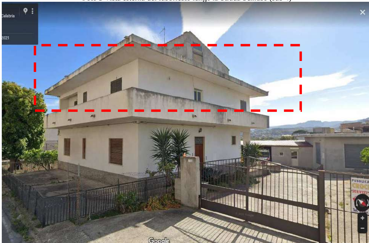
Foto 4 Vista esterna del fabbricato lungo la Strada Scinuso (sub 4)
