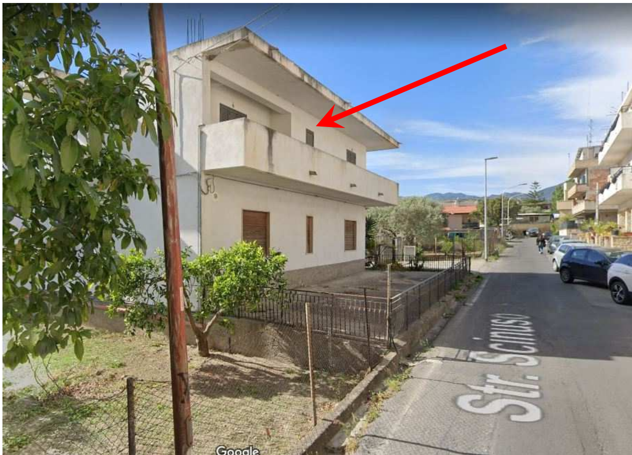
Foto 3 Vista esterna del fabbricato lungo la Strada Scinuso (sub 4)
