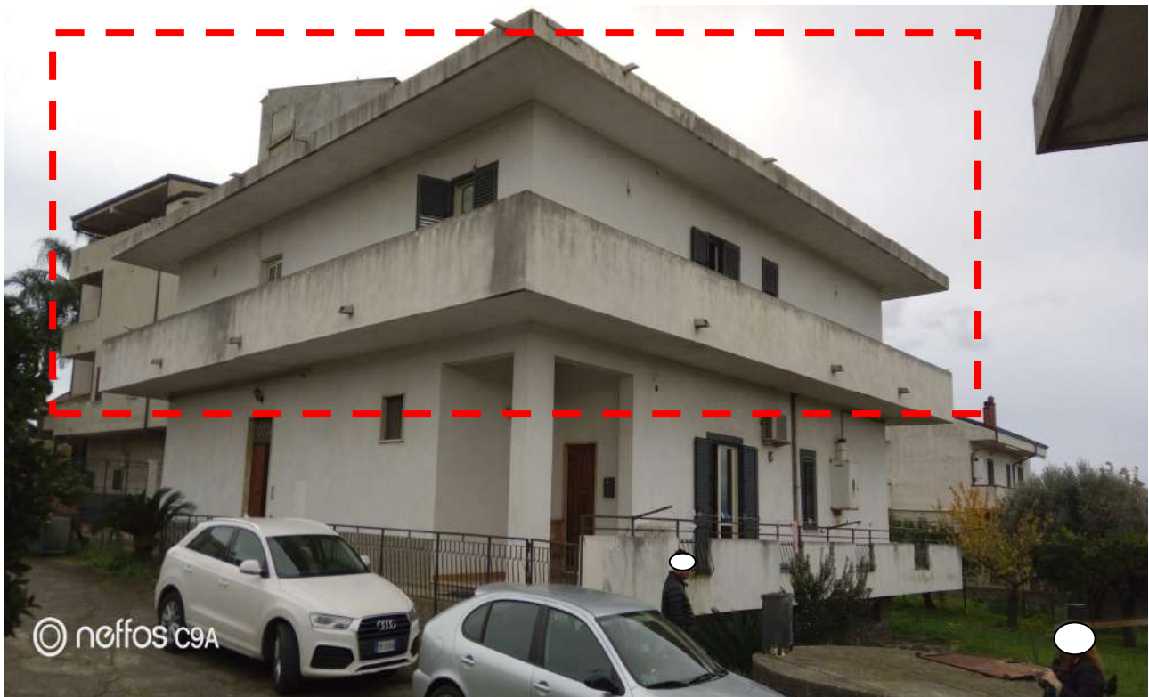
Foto 5 Vista esterna del fabbricato, all'interno del lotto, lato Nord-Ovest (sub 4)
