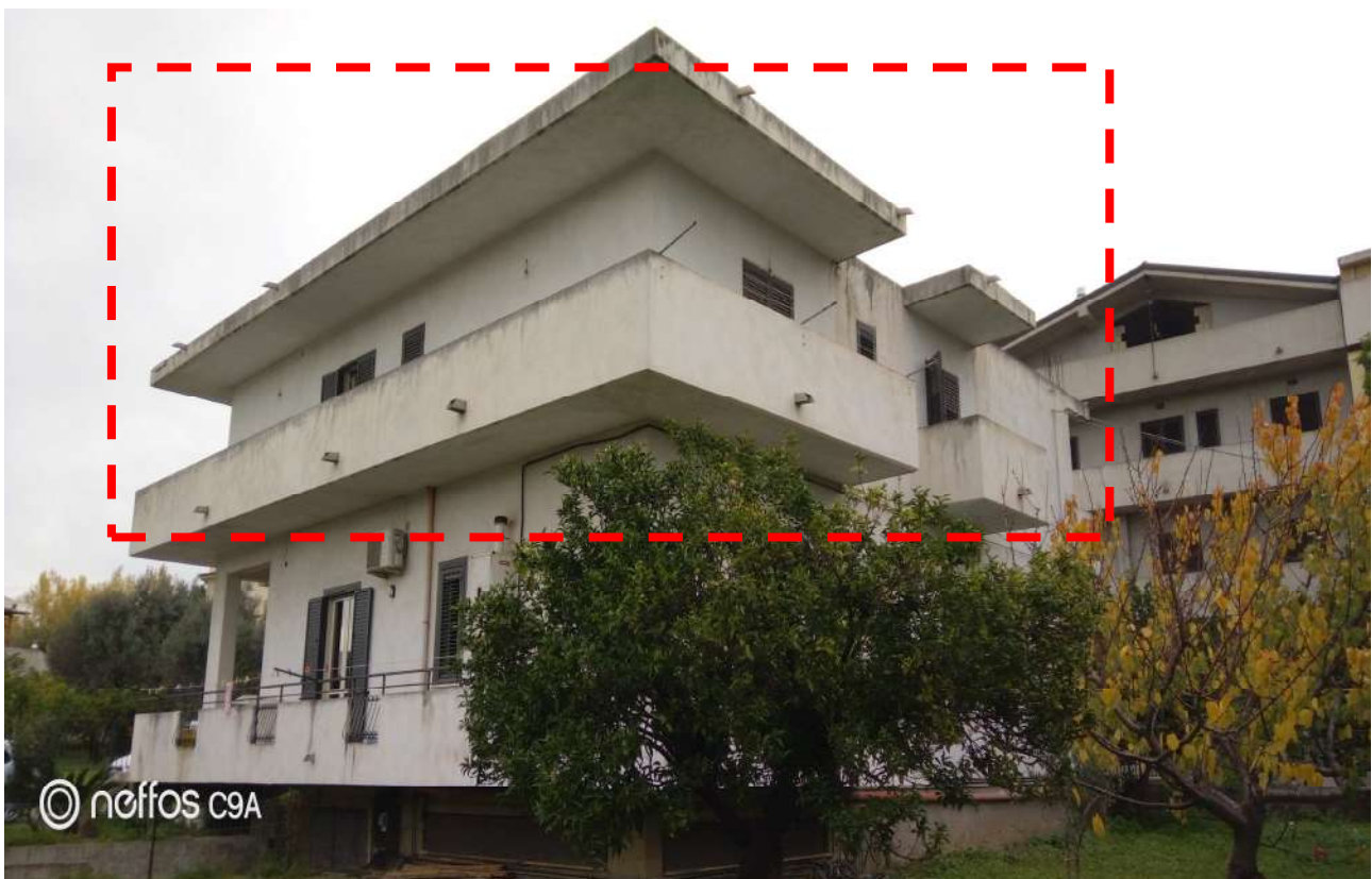
Foto 6 Vista esterna del fabbricato, all'interno del lotto, lato Sud-Ovest (sub 4)
