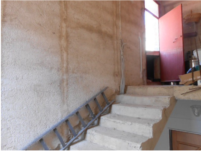
2. La rampa di scala grezza del torrino scala che conduce al 2° piano. Dalla porta aperta si intravede lo spessore del tetto termico a pannelli sandwich e il relativo bassissimo sottotetto determinatosi sul lastrico solare originario.
