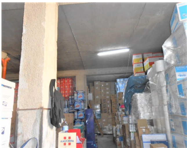
6. Interno del magazzino
