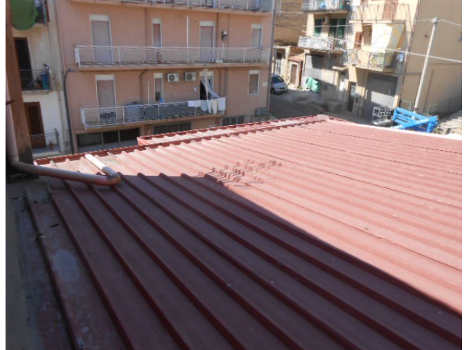
3. La falda del tetto a pannelli grecati orientata verso Via Gagini.
