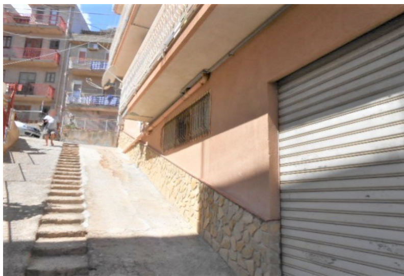
2. Ingresso del magazzino dal vicolo cieco privato con accesso dalla Via Giardinello - Trabia
