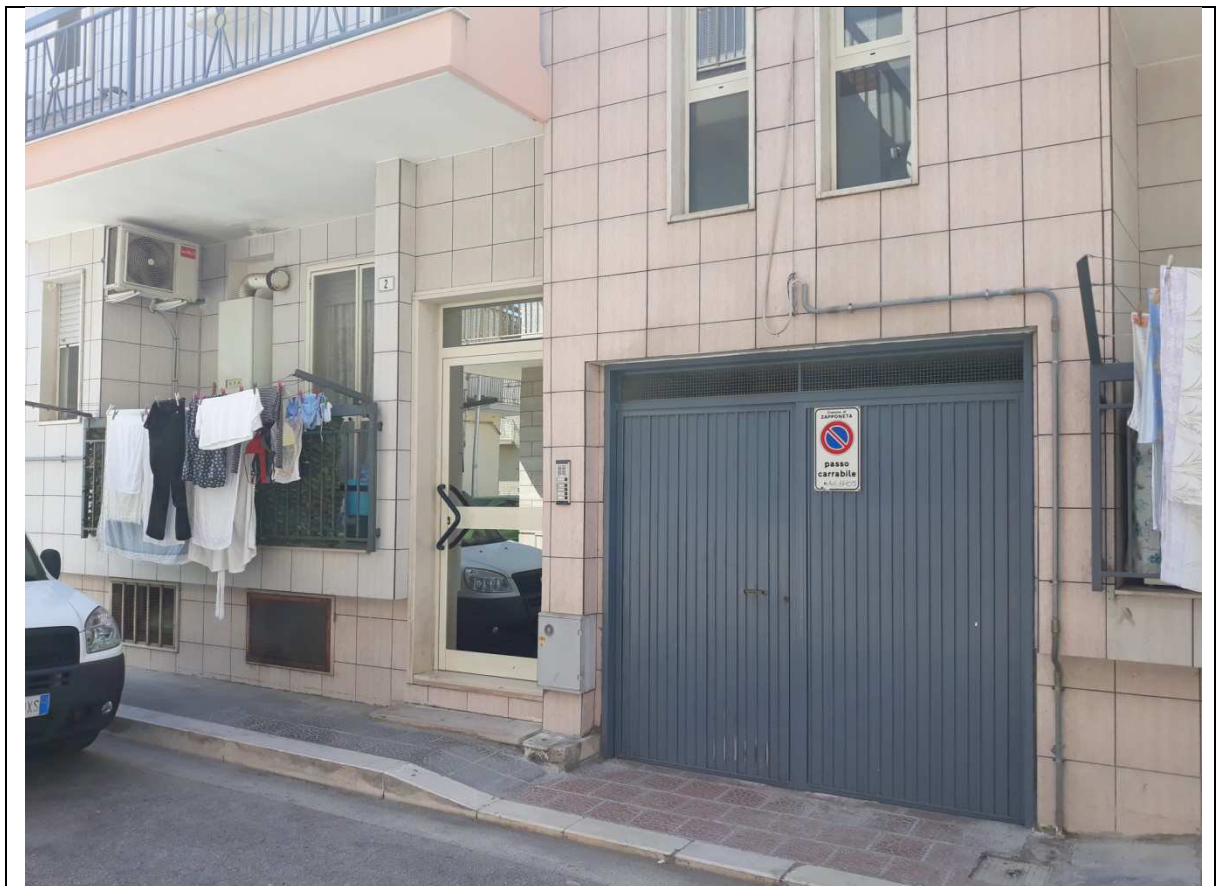
Foto 12 – (Portone di ingresso del fabbricato ed accesso box interrati).
