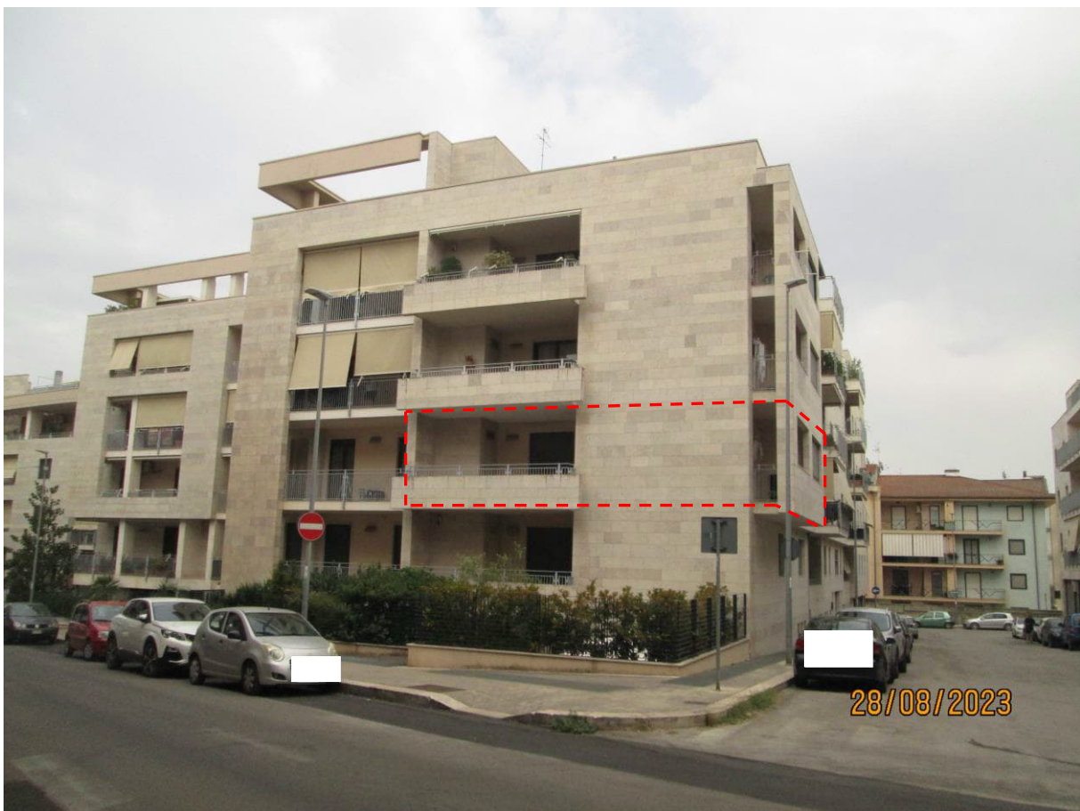
Vista della palazzina “C” da Via Manfredonia, con delimitazione dell’appartamento lotto 3
