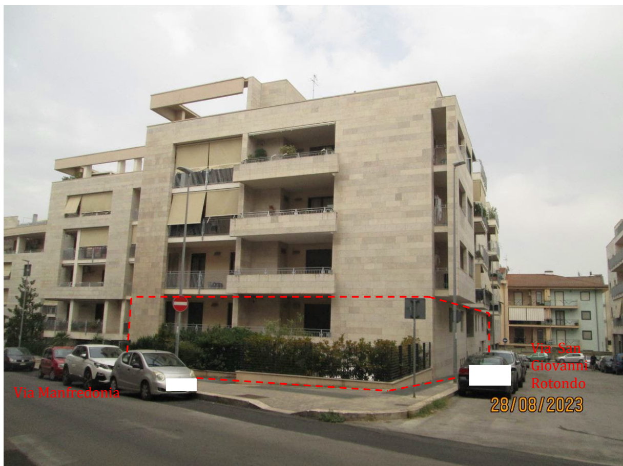
Vista della palazzina “C” da Via Manfredonia angolo Via San Giovanni Rotondo, con delimitazione del lotto 1
