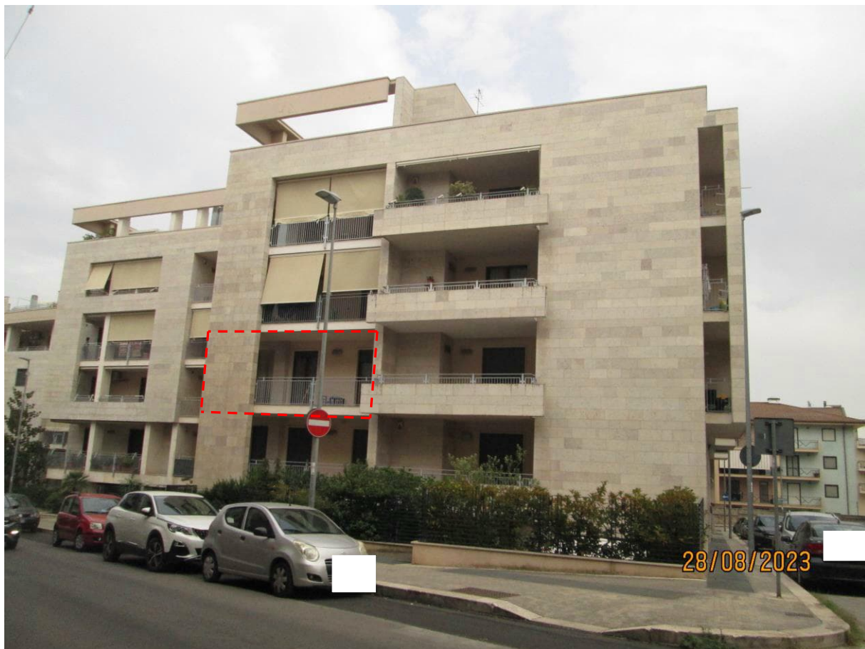
Vista della palazzina “C” da Via Manfredonia, con delimitazione dell’affaccio del lotto 2
