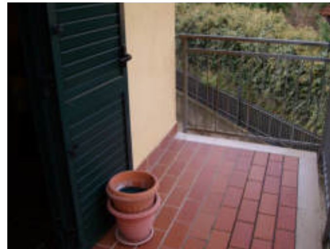
Foto n°22: Balcone Camera da Letto 1
