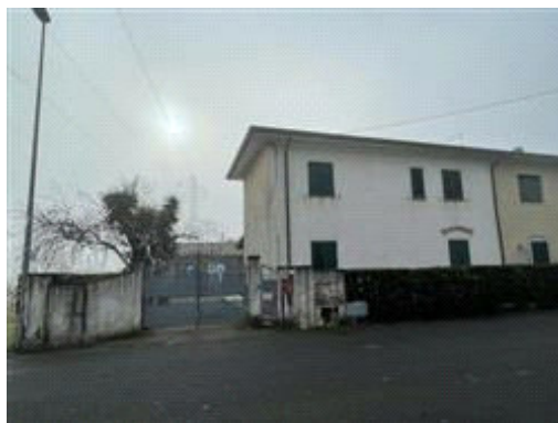
Fronte su via del Paduletto
