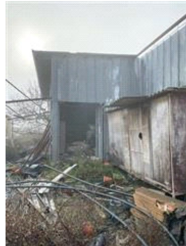
Manufatto in lamiera condonato
