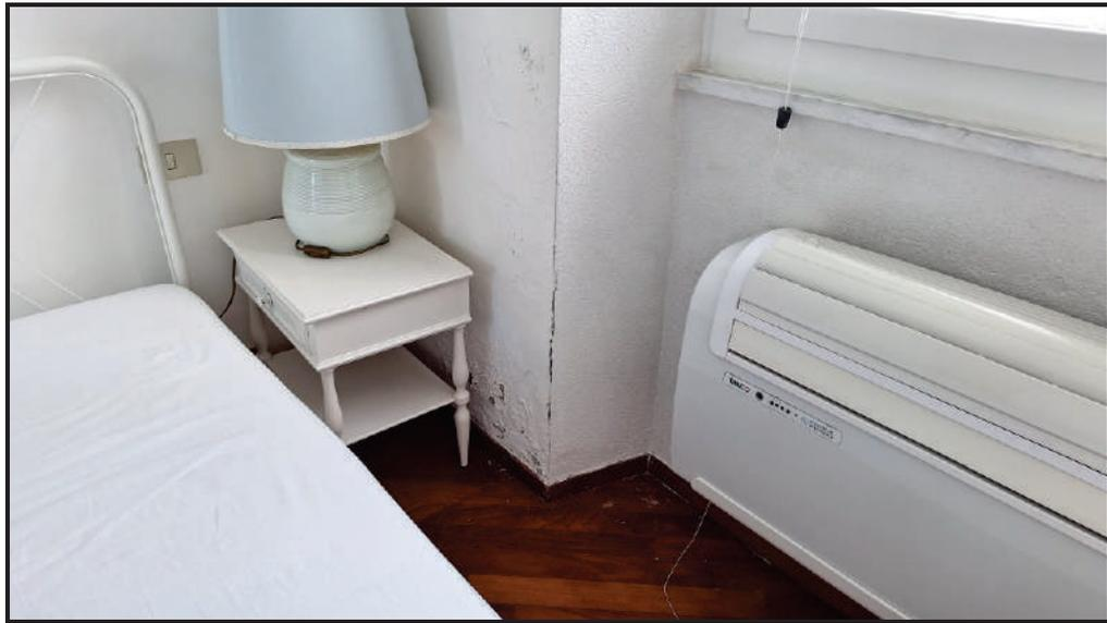
**FOTO N. 14 – Piano terra – Camera – Macchie di umidità da parete esterna**
