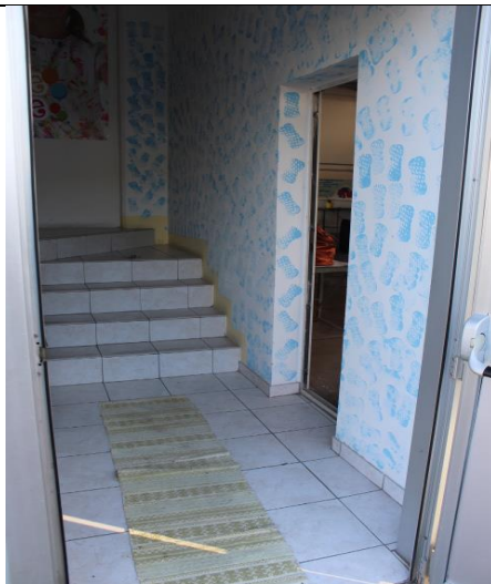
PORTA DI COLLEGAMENTO DEL CAPANNONE CON IL VANO SCALA
