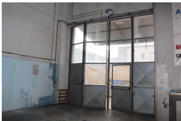
CAPANNONE -AUTOLAVAGGIO- PARTICOLARE PORTONE
