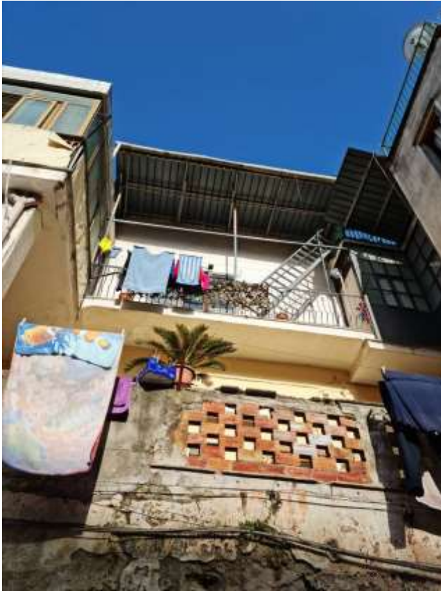
Veduta esterna del fabbricato verso il secondo piano da ovest
