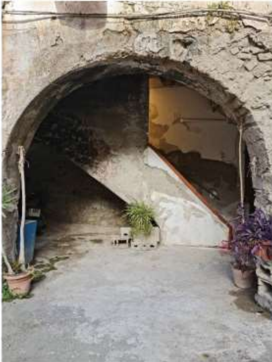
Veduta del varco d'accesso alla scala condominiale
