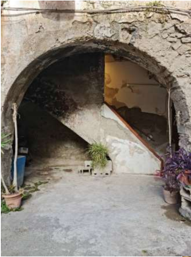
Portone d'accesso al fabbricato
