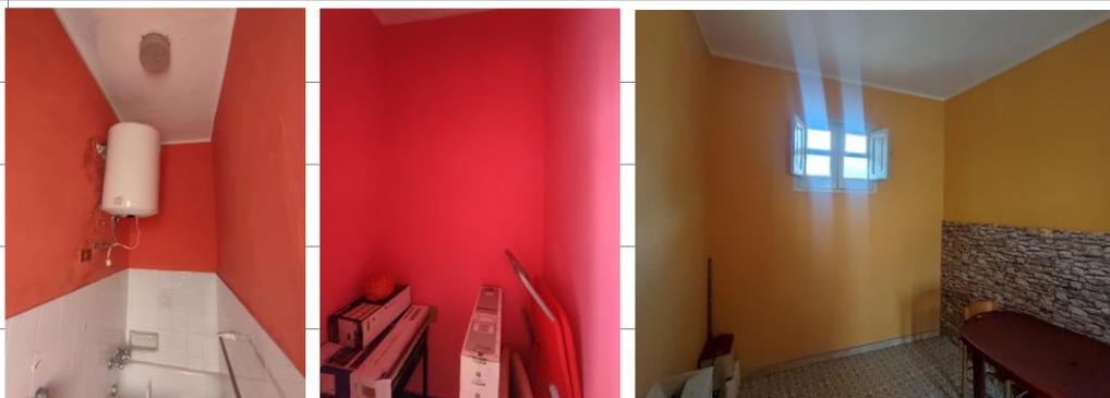
Le pareti dei servizi igienici sono rivestite, con piastrelle in ceramica fino ad un'altezza di ca. 1,60 m. Le pareti degli altri vani sono rifinite con intonaco civile e pittura idrolavabile. La cucina presenta solo una fascia di rivestimento
