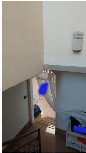
Vano aperto immobile piano terra
