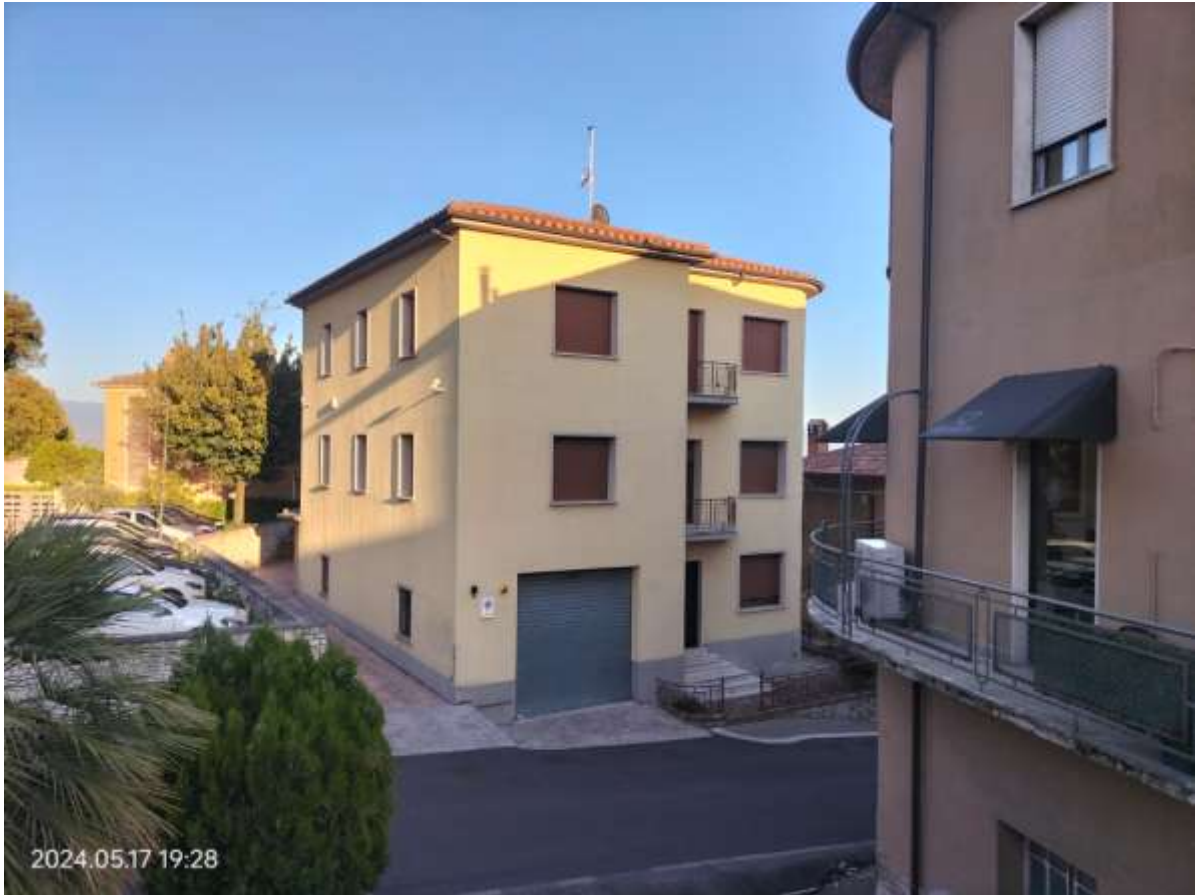
esterno fabbricato - vista lato nord/ovest
