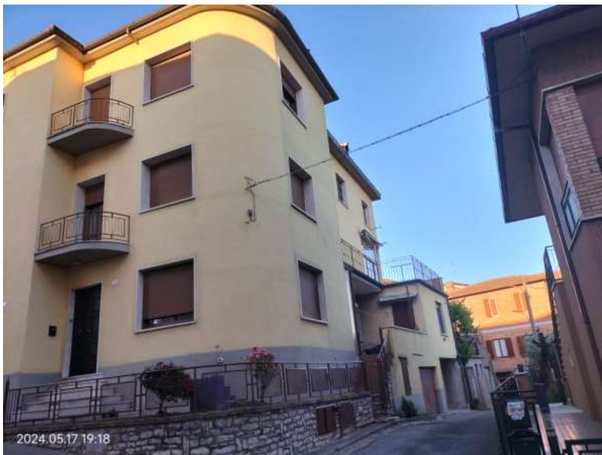
esterno fabbricato - vista lato sud/ovest
