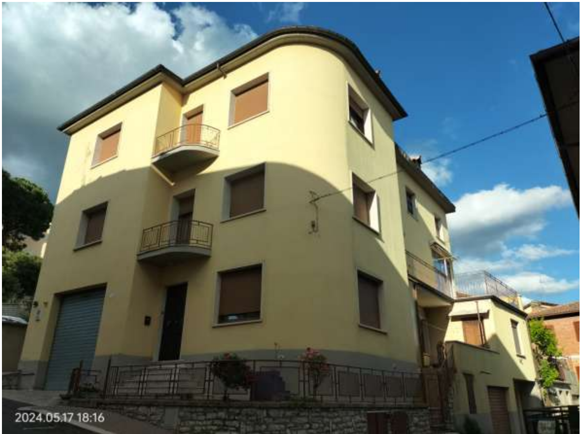
esterno fabbricato - vista lato sud/ovest
