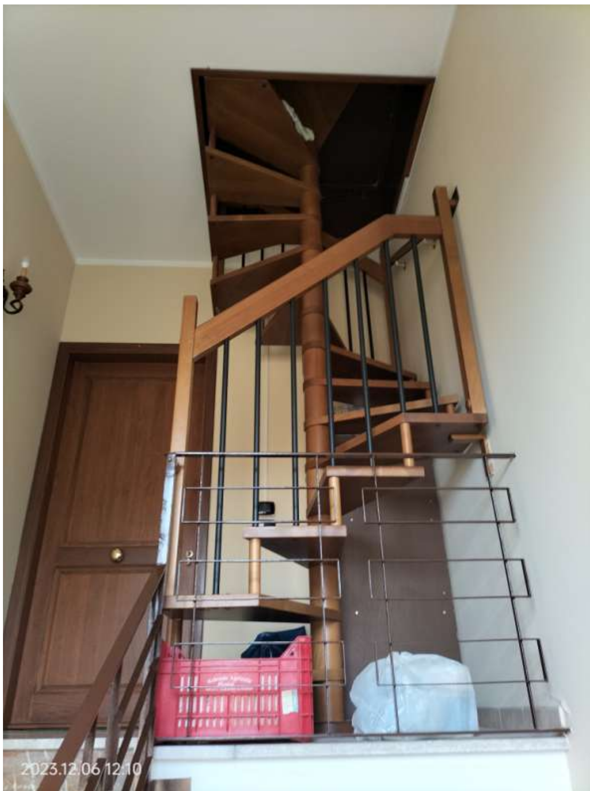
scala a chiocciola di accesso al terrazzo di copertura dal vano scala comune
