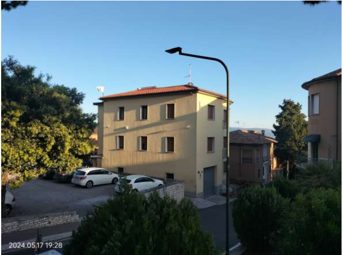
esterno fabbricato - vista lato nord/ovest (dalla strada comunale)
