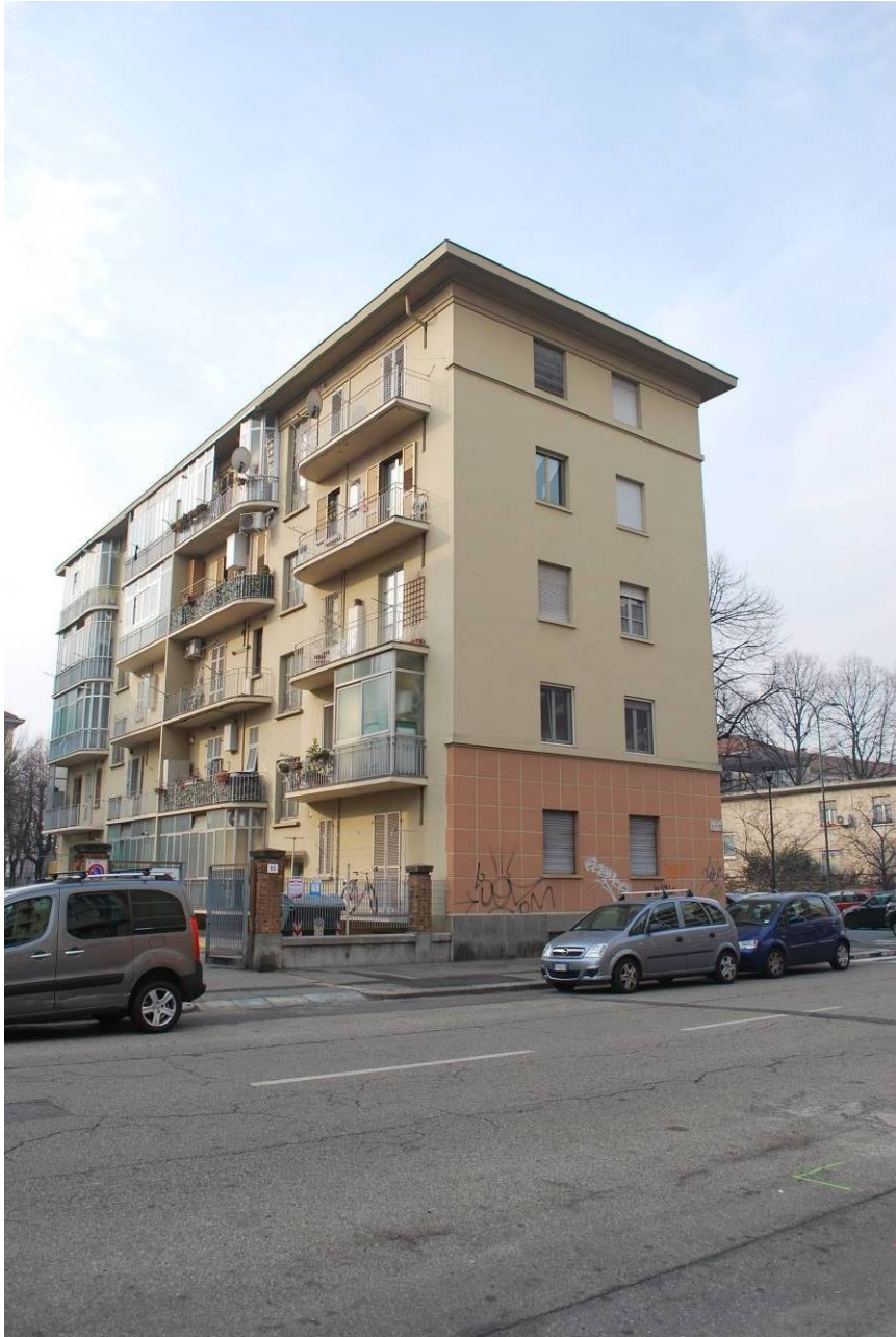
Immobile oggetto di esecuzione in via C. del Prete 65/31 – Torino: vista dalla via pubblica.
