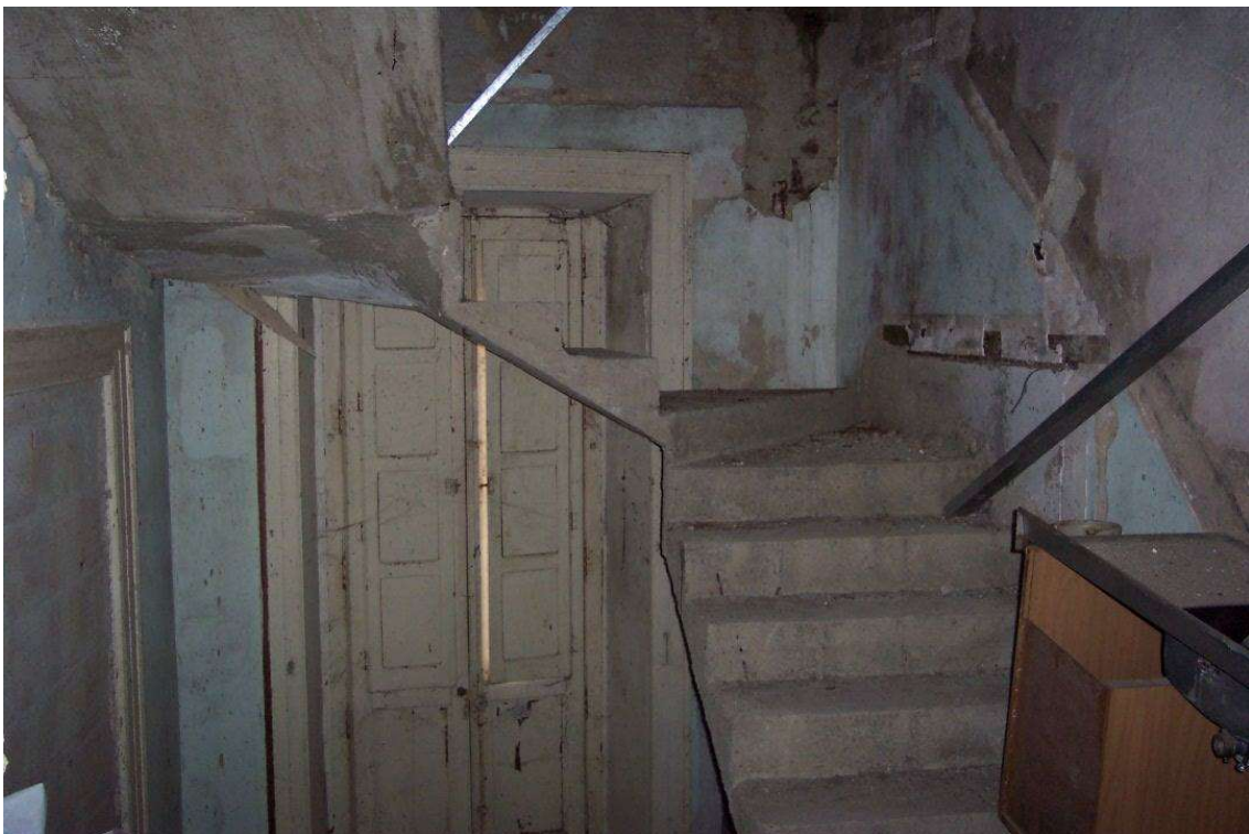
Foto 6 – Lotto 2: Rampa di accesso al vano mansarda
