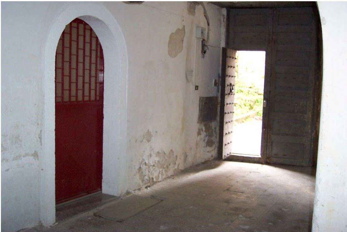
Foto 2 – Lotto 1 – Ingresso locale deposito piano terra particella 64 sub 11
