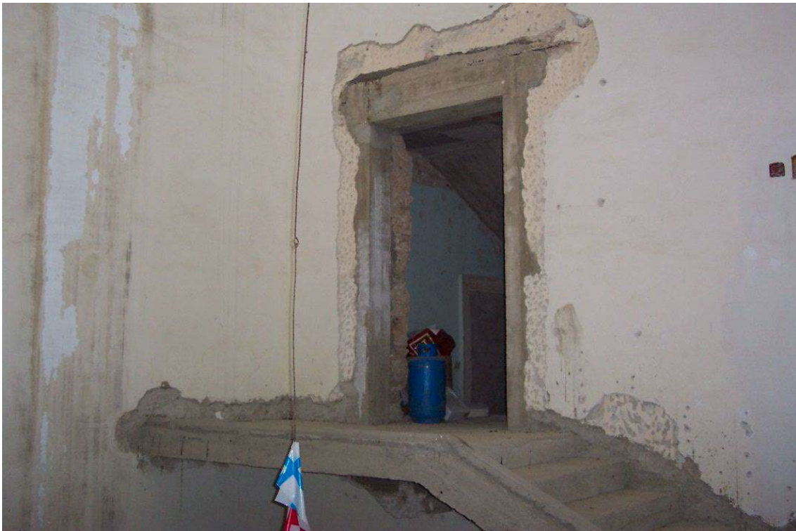
Foto 5 – Lotto 2: Rampa per accesso al vano scala della mansarda particella 74 sub 14
