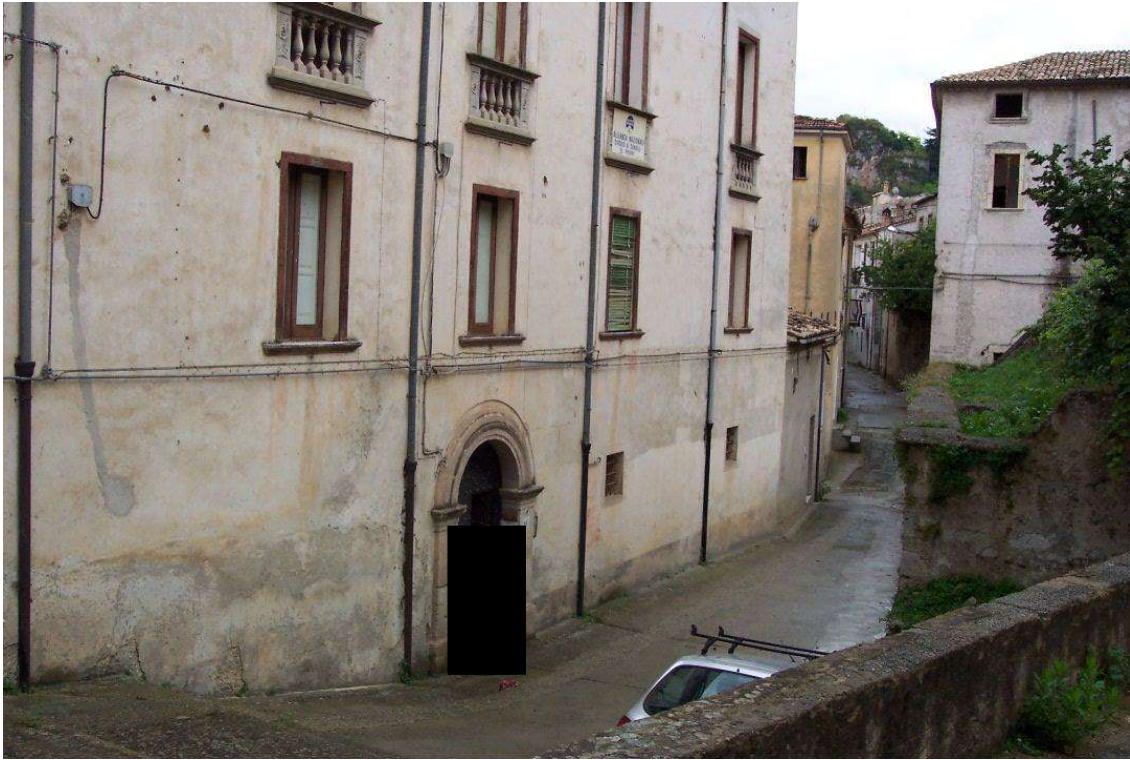
Foto 1 – Fabbricato – vista esterna
