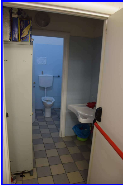
Particolare anti-bagno con vista sul bagno al piano terra
