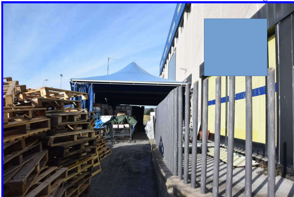
Particolare prospetto laterale con vista su gazebo e corte esterna
