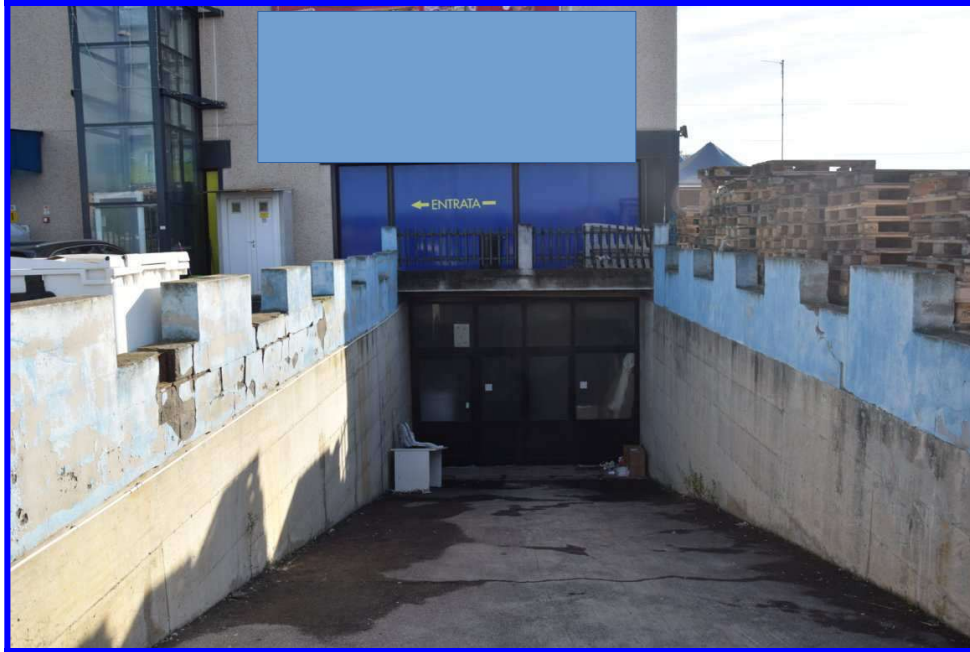
Particolare ingresso al piano interrato da via Caduti sul Lavoro
