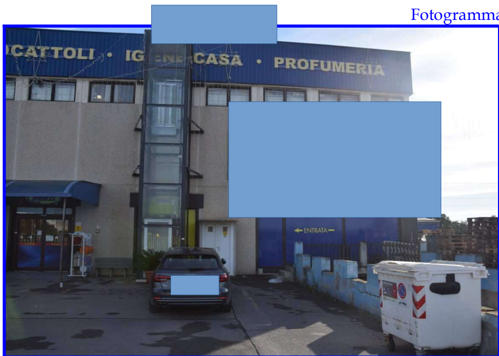
Particolare ingresso con vista sull'ascensore
