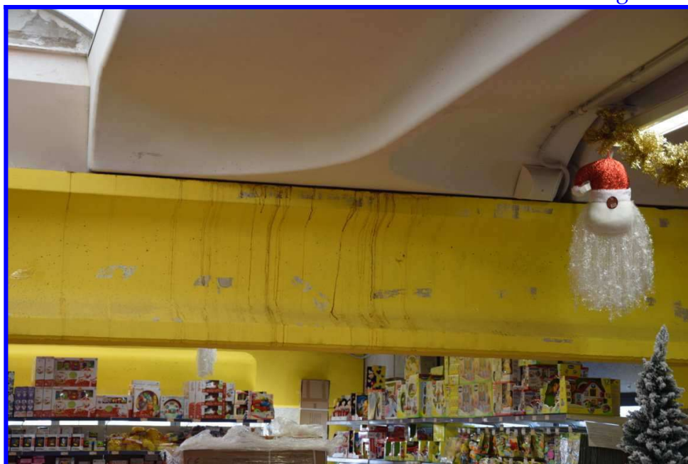
Particolare area vendita al piano primo con vista sulla trave
