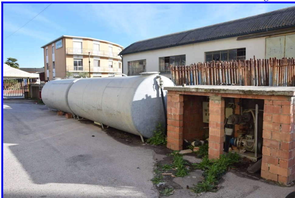
Particolare corte esterna con vista su depositi acqua e manufatto per autoclave
