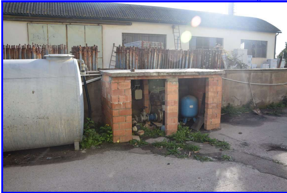
Particolare corte esterna con vista su deposito acqua e manufatto per autoclave
