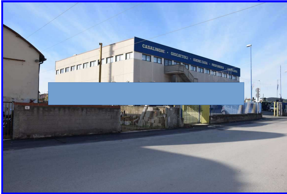
Particolare prospetto laterale su via dell'Agricoltura con vista su gazebo esterno
