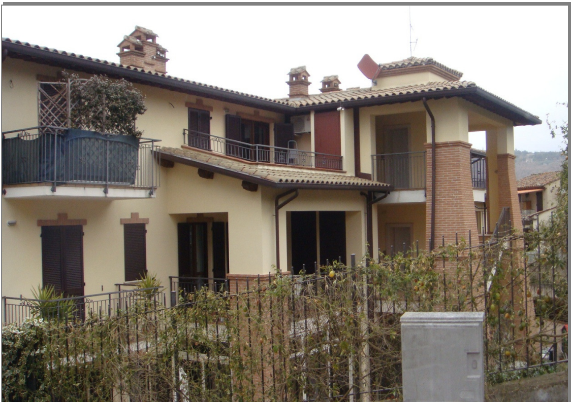
Foto n° 2 Vista tergale del fabbricato condominiale
