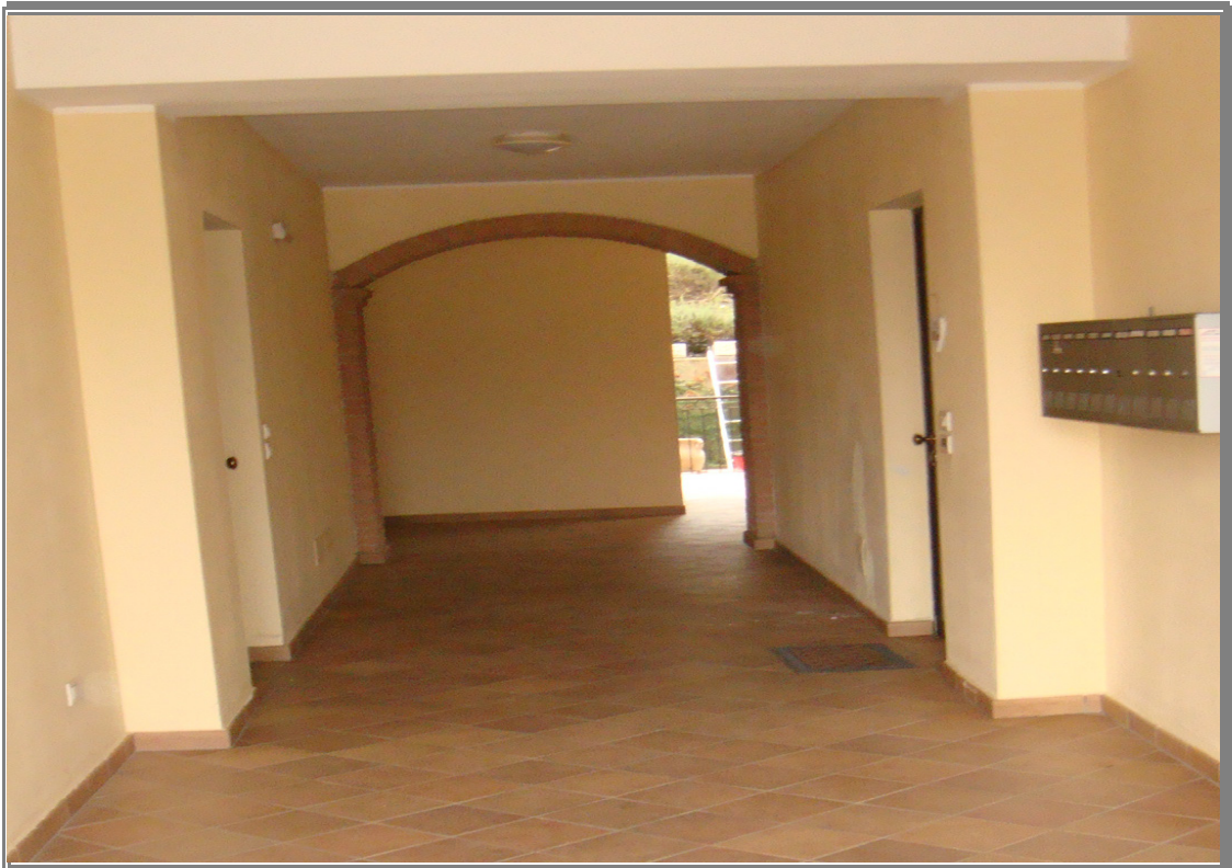
Foto n° 7 Atrio condominiale coperto
