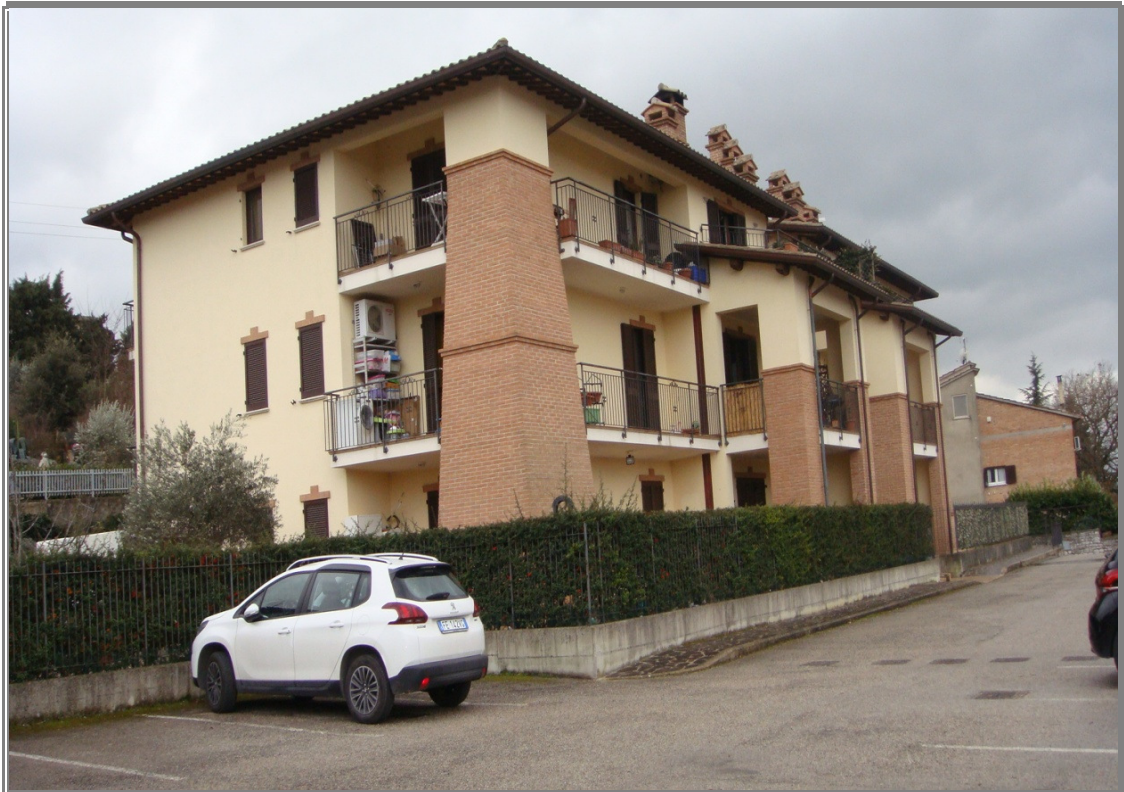
Foto n° 1 Vista frontale del fabbricato condominiale
