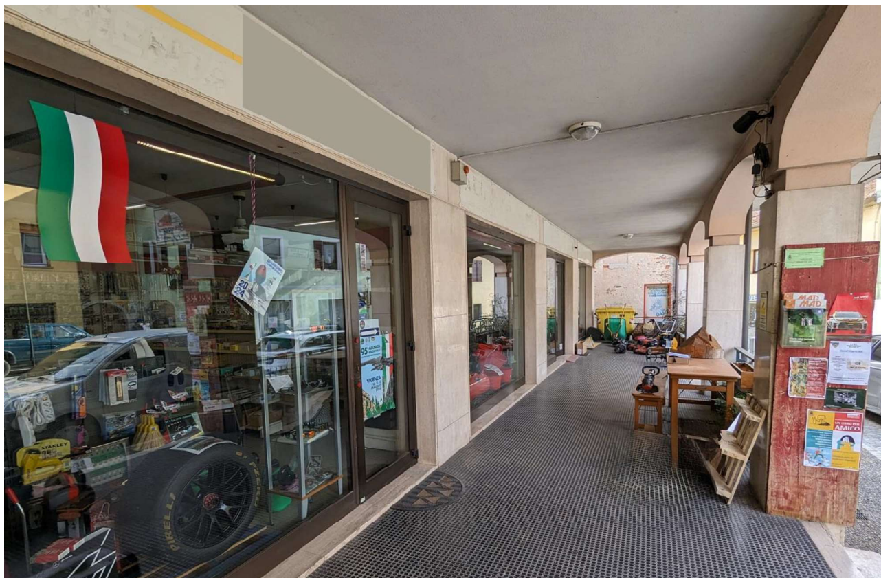
Piano terreno - Esterno dell'immobile, sotto i portici.
