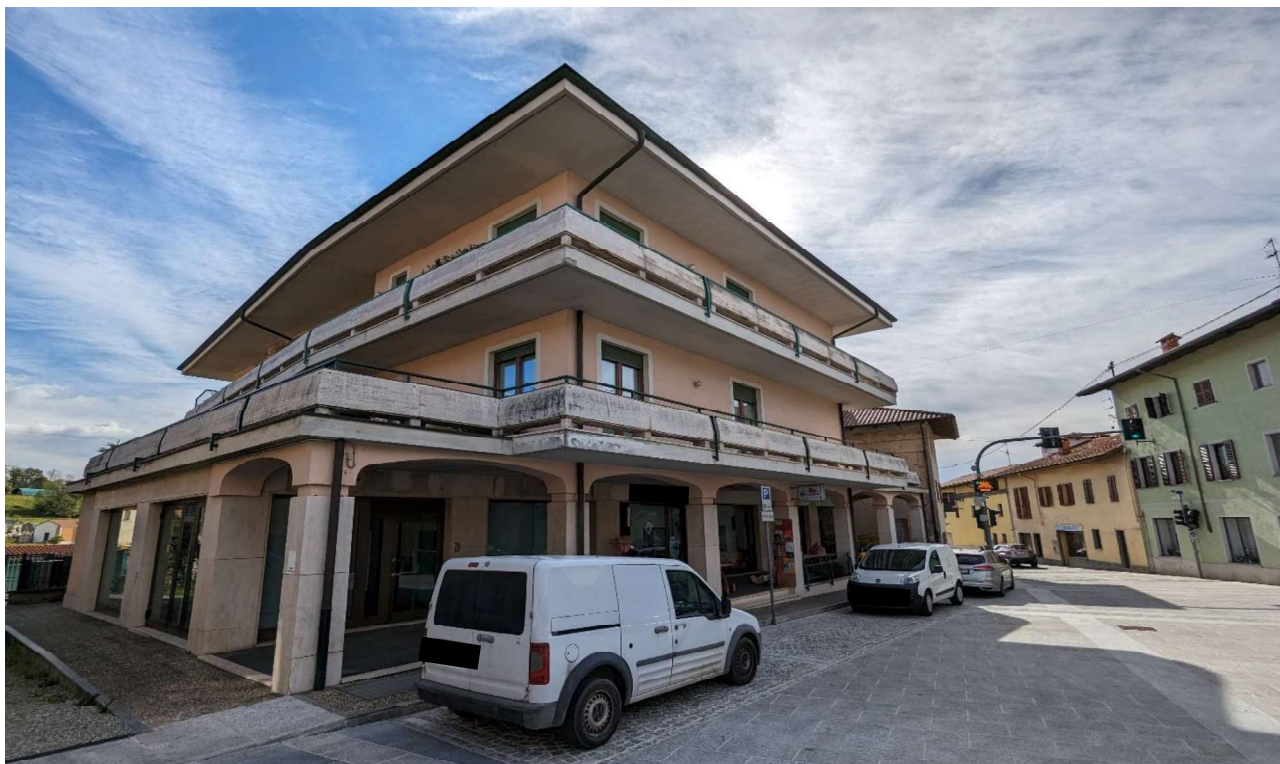
Piano terreno - Esterno dell'immobile generale.
