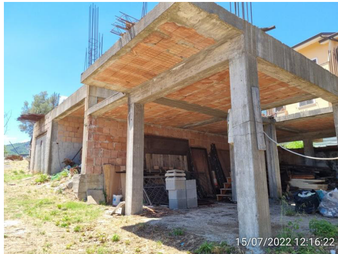
Foto 4.2_1 – Struttura in c.a.
