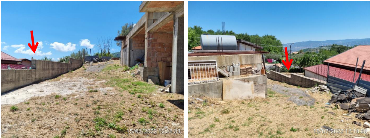
Foto 4.2_2 e 3 – Muro di sostegno in c.a
