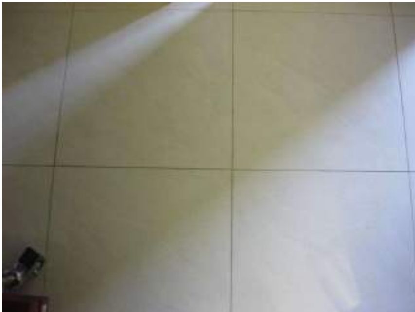
Fabbricato sito in via P. Borsellino n.263/A – Particolare pavimenti immobile part. 1188 sub.49
