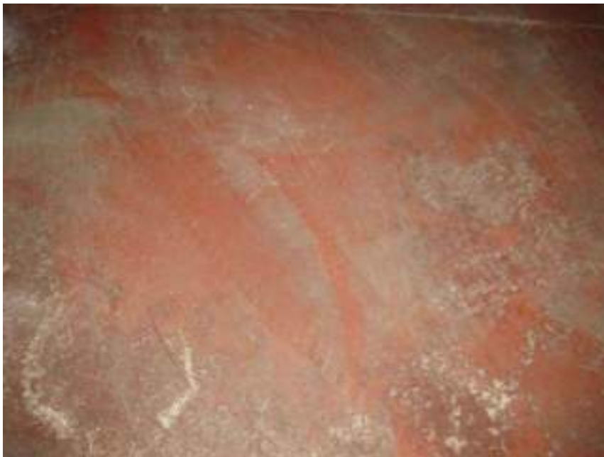
Fabbricato sito in via P. Borsellino n.263/A – Box - immobile part. 1188 sub.10 – particolare della pavimentazione
