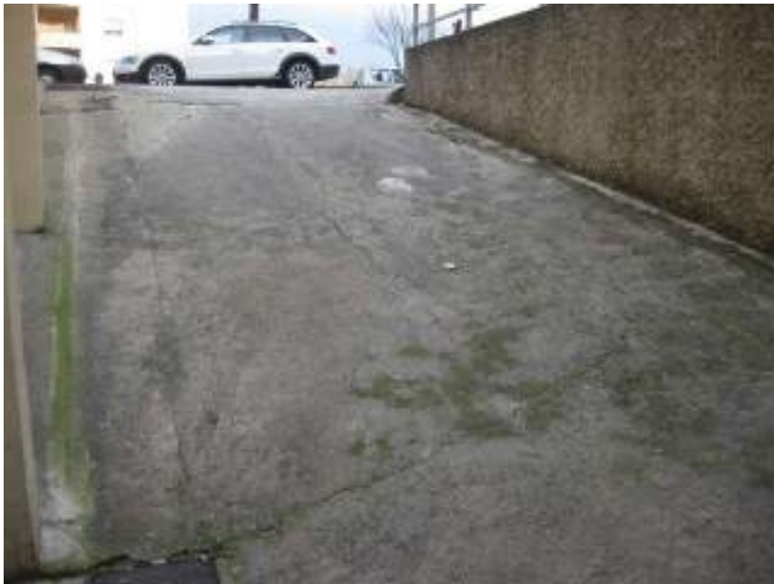
Fabbricato sito in via P. Borsellino n.263/A – Box - immobile part. 1188 sub.10 – ingresso da viale G. Mancini
