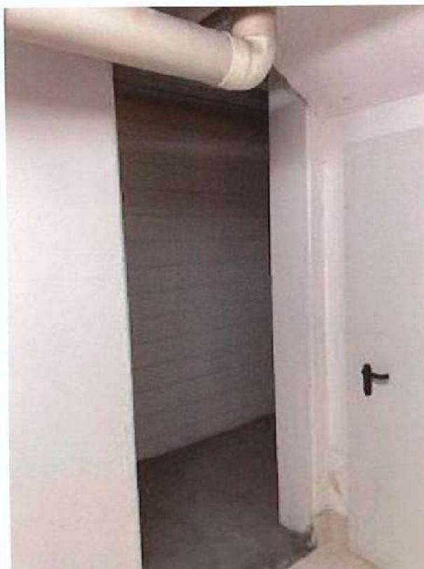
Vista 14 - Ingresso alla cantina.
