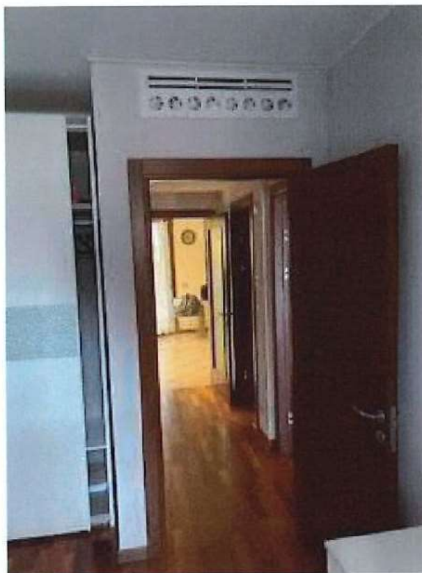
Vista 11 - Particolare del disimpegno, zona giorno nello sfondo.
