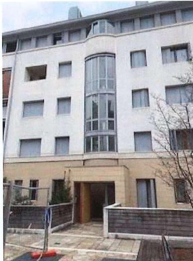
Vista 1 - Ingresso condominiale.
