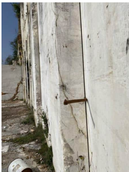
Parete sul fronte
