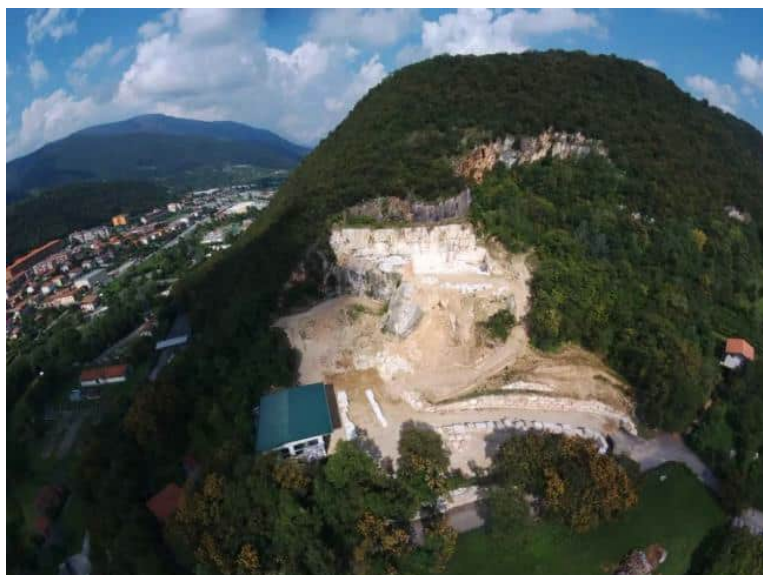
Vista aerea della cava
