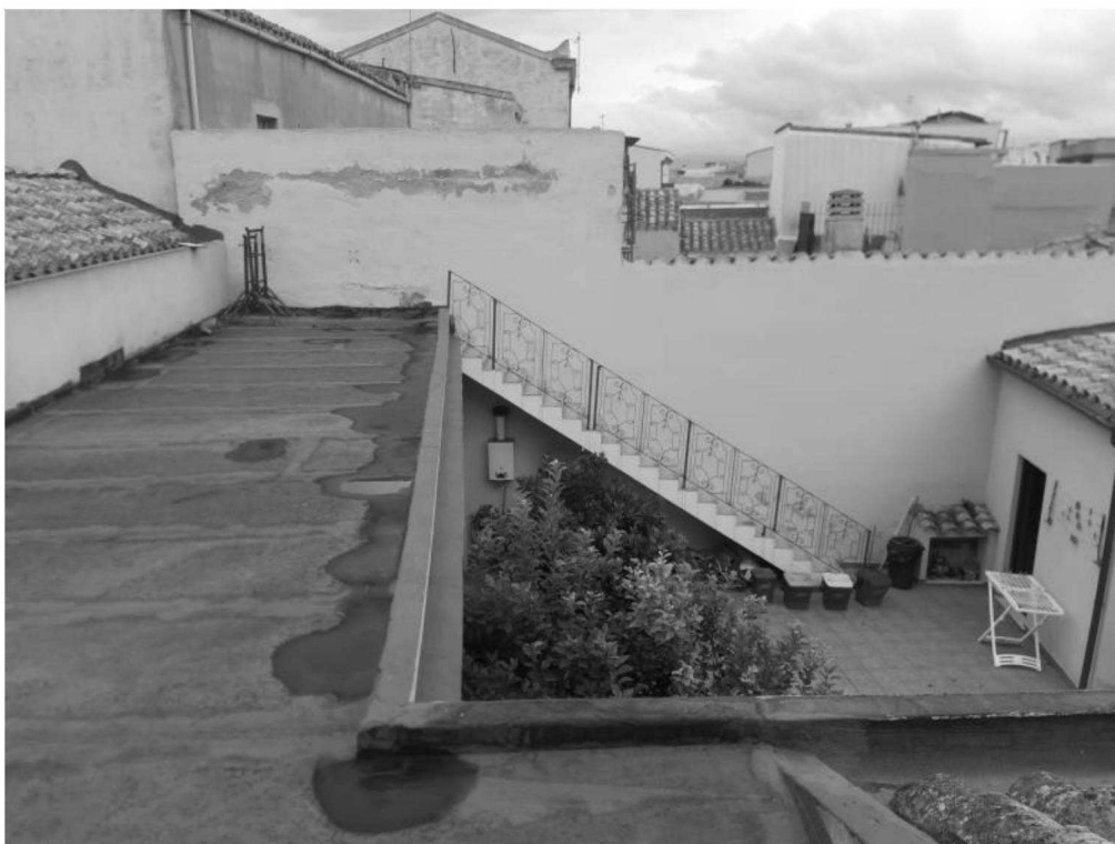
Foto 14. Terrazza primo piano (copertura piana del sottostante loggiato)
