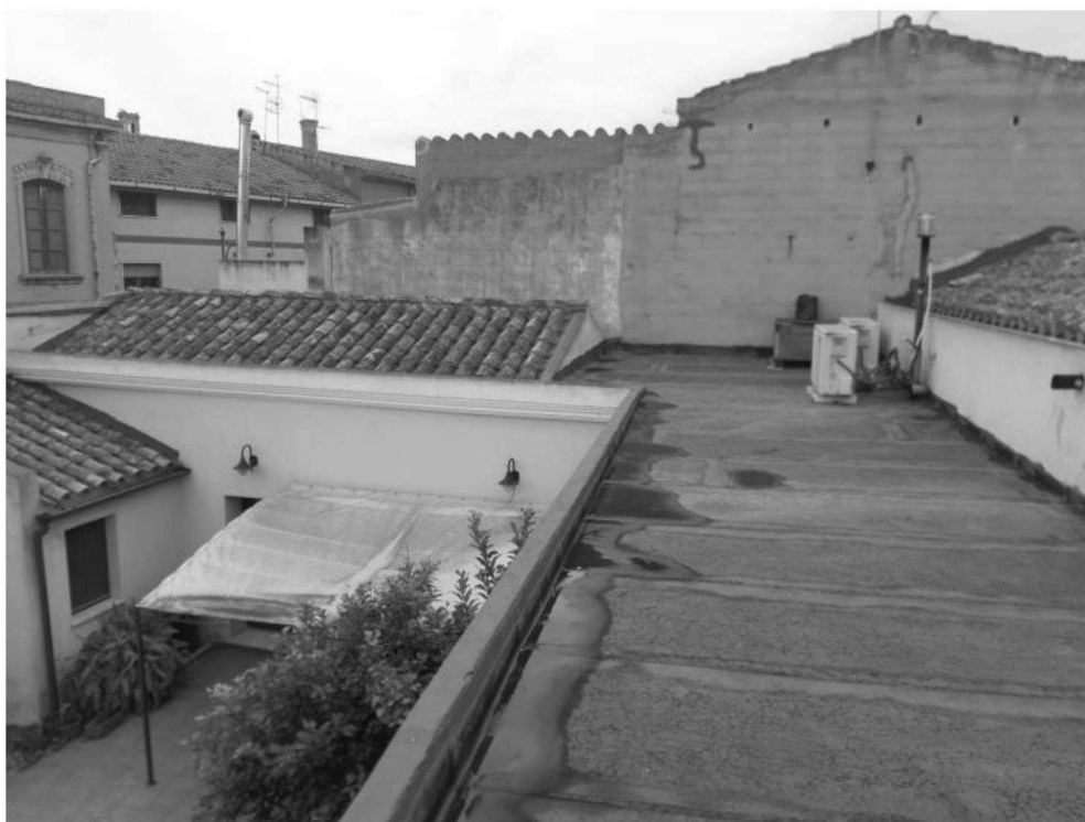
Foto 12. Terrazza primo piano (copertura piana del sottostante loggiato)
