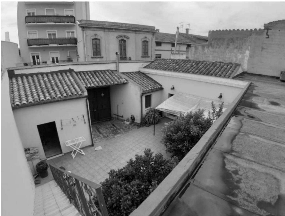
Foto 17. Vista della corte e delle interna e delle coperture, dalla terrazza del primo piano
