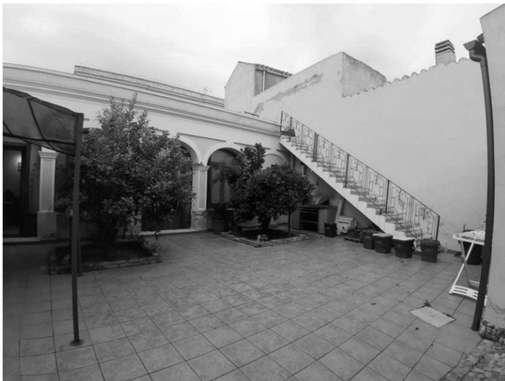
Foto 8. Vista della corte interna - Particolare della scala in muratura che porta alla terrazza esterna
