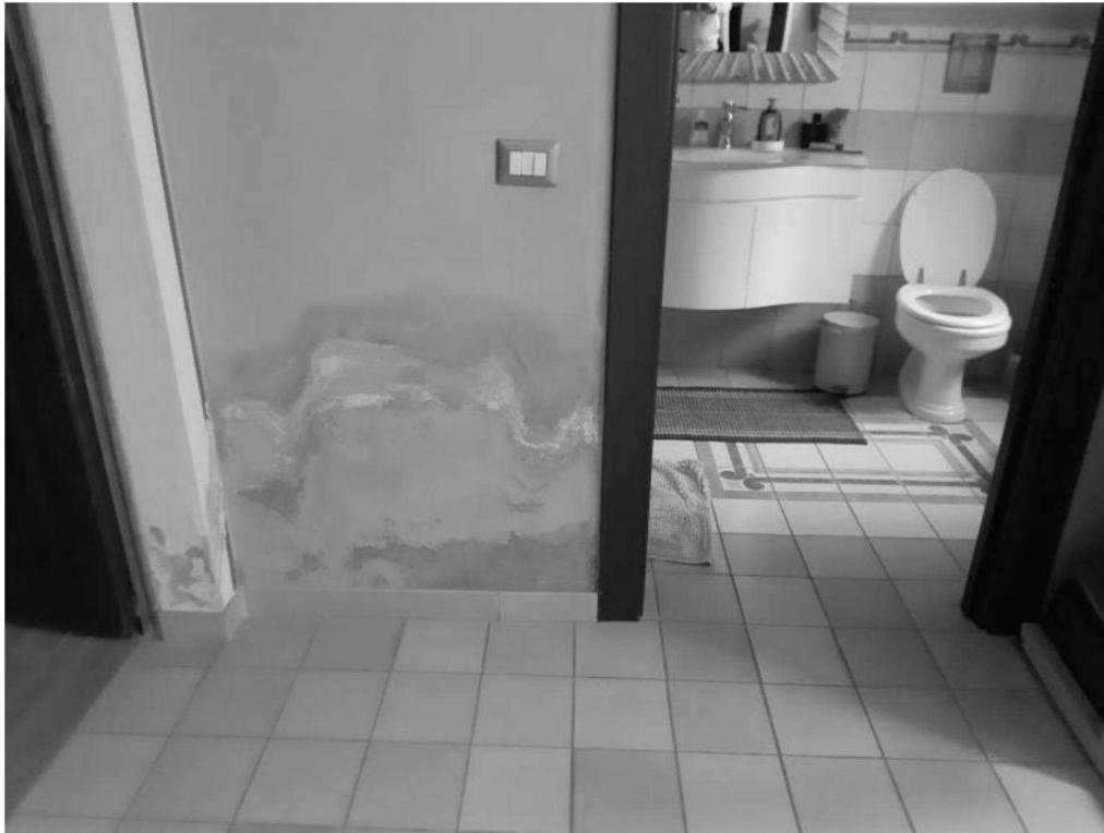
Foto 41. Bagno zona notte - Particolare di alcuni fenomeni di umidità di risalita capillare
