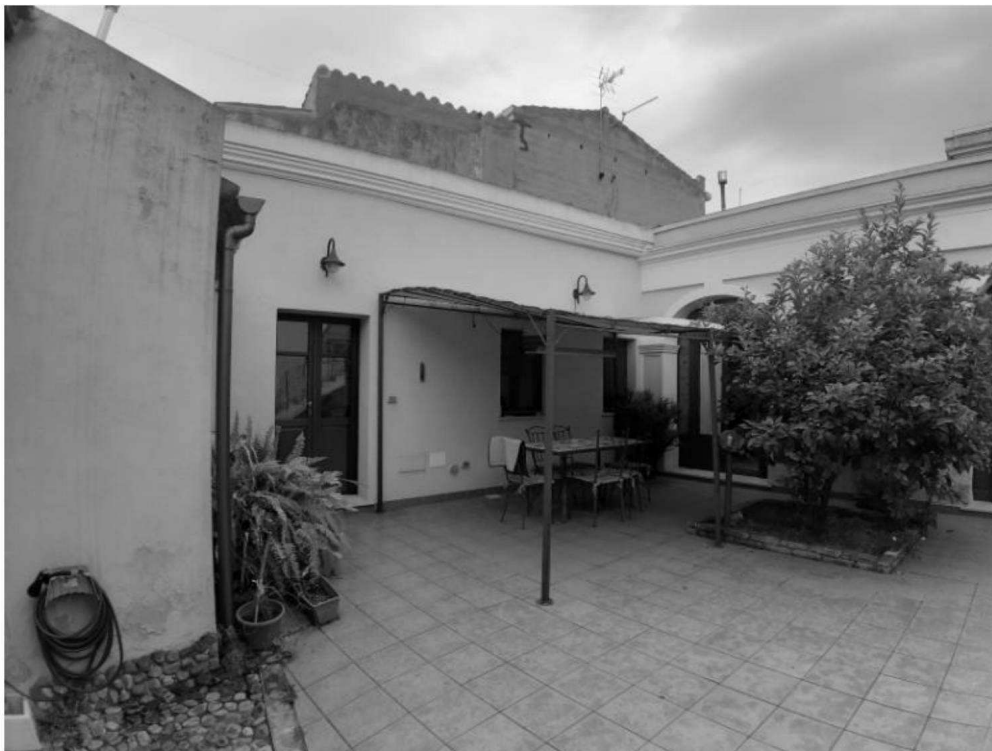
Foto 7. Vista della corte interna
