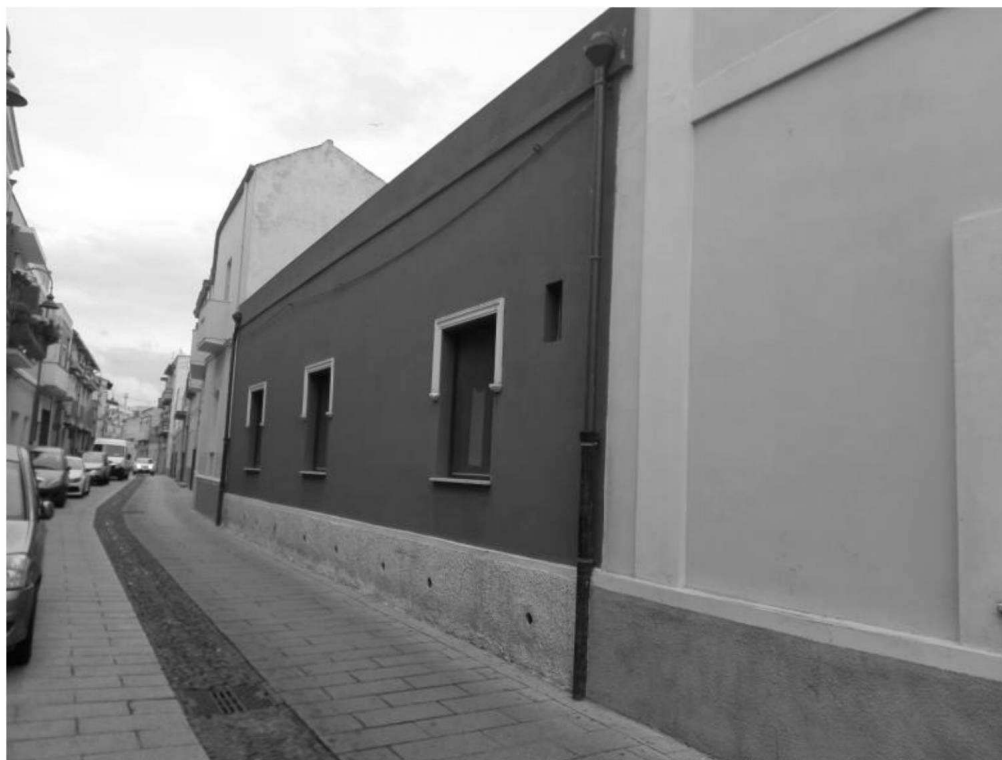
Foto 19. Prospetto esterno lato Via Garibaldi
