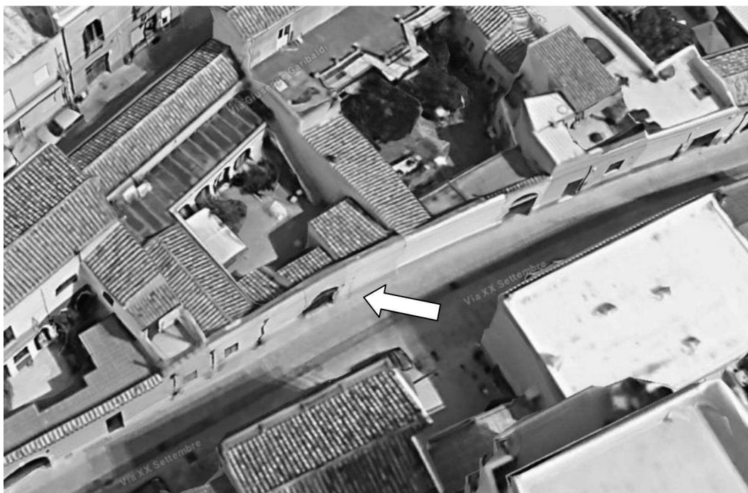
Foto 1. Vista dall'alto del fabbricato oggetto di perizia
