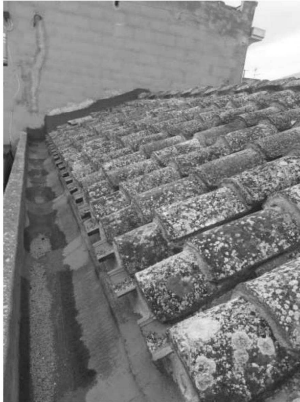
Foto 15. Particolare del manto di copertura in tegole curve (coppo sardo)
