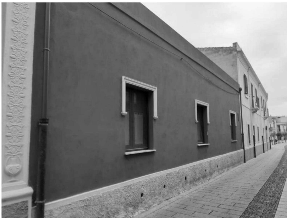
Foto 20. Prospetto esterno lato Via Garibaldi
