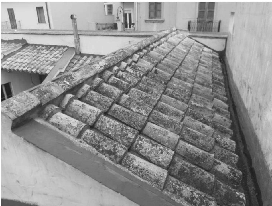
Foto 16. Particolare del manto di copertura in tegole curve (coppo sardo)
