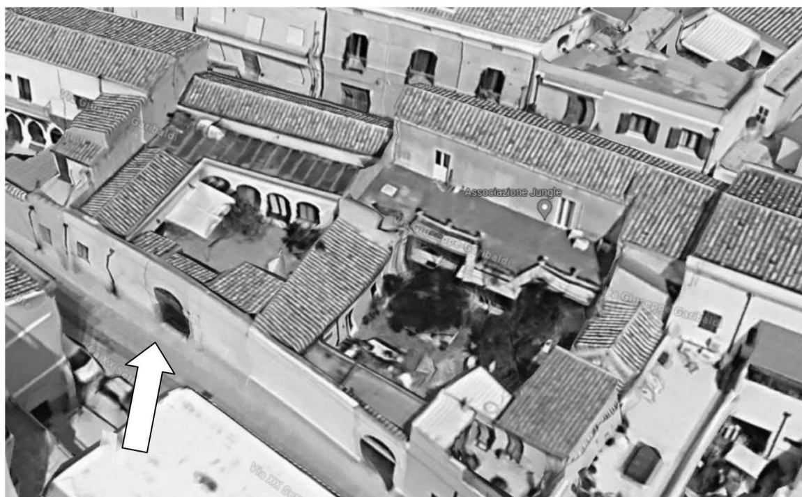
Foto 2. Vista dall'alto del fabbricato oggetto di perizia
